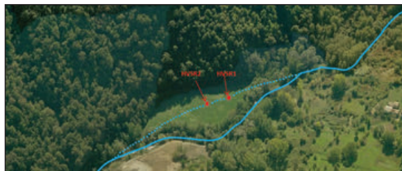
Figura 17 – Deviazione del percorso idrico e, misura dello spessore delle alluvioni su bedrock (noise ambientale): sito 3A
