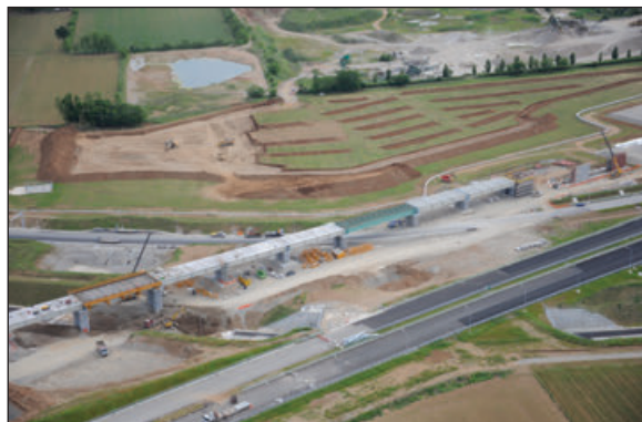
Figura 6 - VI09, Realizzazione impalcato metallico su svincolo autostrada Bre.Be.Mi
