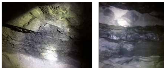
Fig. 21 - Galleria Pavoncelli bis pk 6170 m fronte scavo: alternanza di arenarie e siltiti arenacee con sottili intercalazioni marnose afferenti alla Formazione delle Arenarie di Corleto-Albanella.
