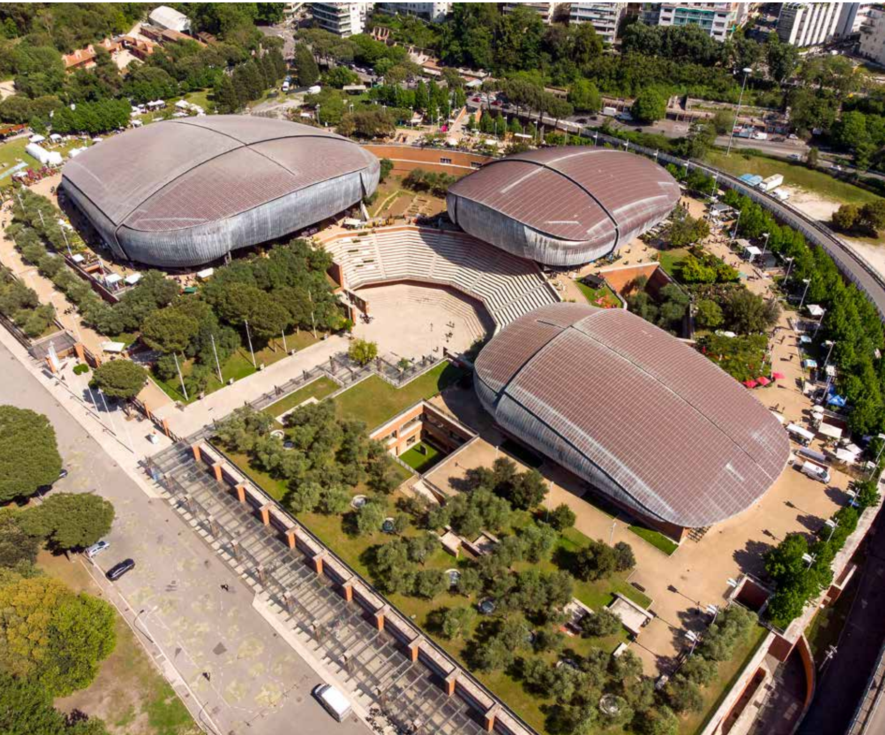
↑ - K Renzo Piano Building Workshop Auditorium Parco della Musica Roma, 1994–2002 Ph © Moreno Maggi Foto aerea
