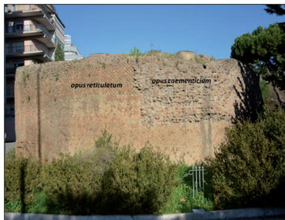
**Fig. 14** - Malta idraulica nella parete del corridoio esterno che copre il paramento in *opus reticulatum*.
