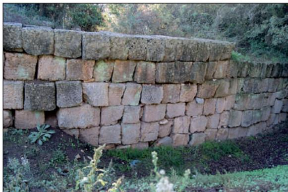
un'altezza non superiore al metro) emerge a quota superiore rispetto al piano di calpestio. Non essendo semplice cavare blocchi regolari, il materiale da costruzione utilizzato aveva forme e dimensioni diverse che davano come esito muri con filari di altezza irregolare e in generale un aspetto di modesta uniformità (fig. 5).
