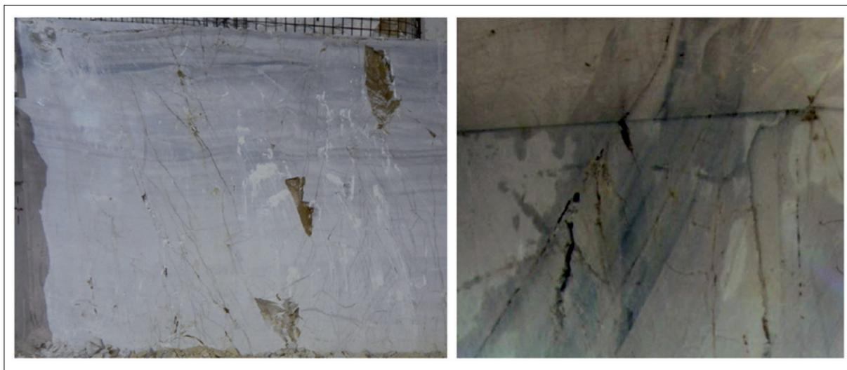
**Figura 15** - Esempi di fratture di neo-formazione all’interno della Cava Romana.
