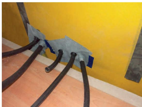
Figura 9. Particolare dell'interruzione di tenuta intorno a un tubo freddo e ad un corrugato elettrico realizzata con collari autoadesivi in EPDM e nastri butilici (con rispettiva tabella materiali).
