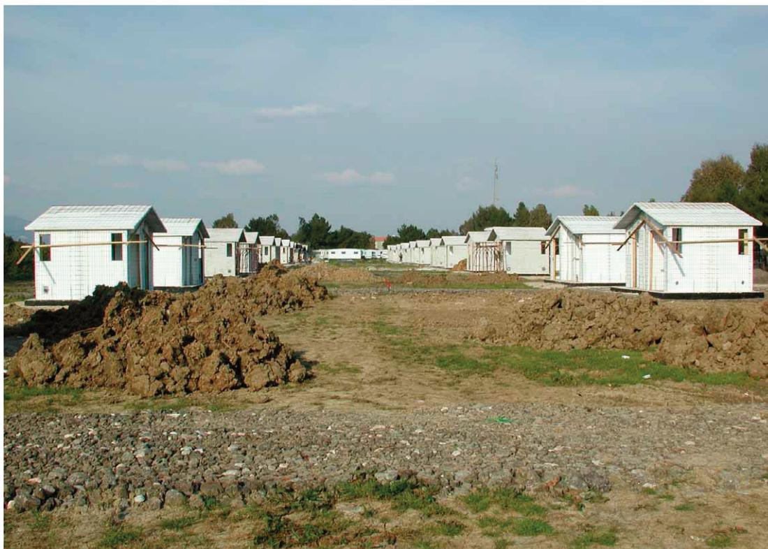
*Figura 6. Primi interventi realizzati con pannello singolo portante (camping).*
