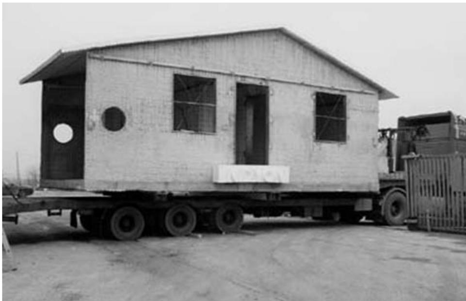
Figura 9. Prototipo di casa mobile realizzata con pannello singolo portante.
