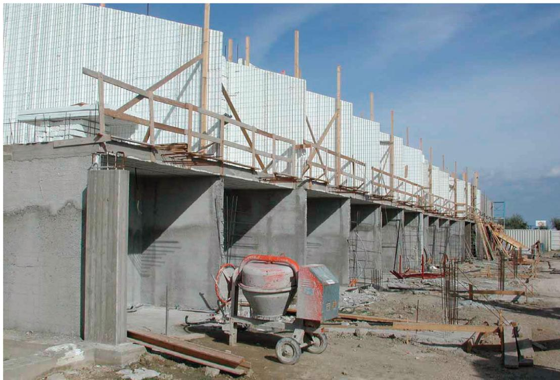
*Figura 7. Edificio in linea a due piani realizzato con pannello singolo portante.*
