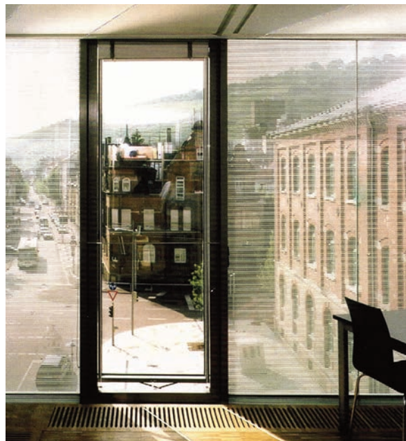
Figura 19. Pur essendo nella configurazione di schermatura estiva, il modulatore solare consente la percezione visiva dall'interno verso l'ambiente esterno (da brochure tecnica della Okalux; sistema Okasolar + Okaflex).
