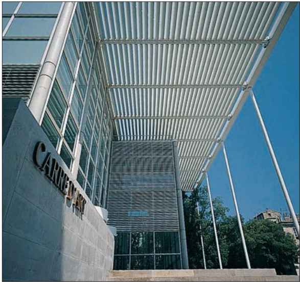
Figura 3. Sistema di schermatura esterna realizzato con aggetto orizzontale a pensilina di tipo fisso ed elementi frangisole a pale. Lo schermo orizzontale, sostenuto da montanti in acciaio in relazione alla rilevante dimensione dell'aggetto rispetto al piano verticale di facciata, è stato realizzato con pale di 470 mm di larghezza e m 5 di lunghezza. (Carré d'Art, museo d'arte contemporanea; Nîmes, Francia; progetto architettonico: arch. Norman Foster; realizzazione del sistema di schermatura: Merlo s.r.l.; immagine tratta per gentile concessione dell'azienda Merlo s.r.l. dal sito www.merlosrl.com ).
