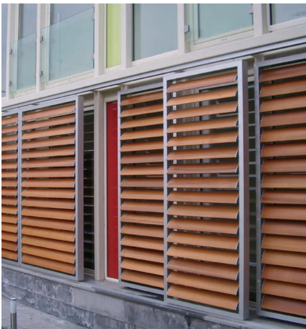
Figura 13. Pannelli frangisole scorrevoli su binari in alluminio, realizzati con telaio perimetrale in alluminio e lamelle orientabili in cedro rosso del Canada. Il movimento dei pannelli è azionato da motori elettrici a 24 V installati all'interno dei montanti. (Edificio Holden a Tbilisi, Georgia; progetto architettonico, arch. Di Gesu; realizzazione del sistema di schermatura esterna: Merlo s.r.l.; immagine tratta dal sito www.merlosrl.com per gentile concessione dell'azienda Merlo s.r.l.).
