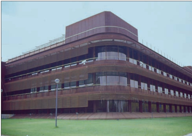
Figura 5. Edificio per uffici (Siviglia, Spagna), con sistema di protezione solare delle facciate costituito da uno schermo verticale ad elementi metallici orizzontali, caratterizzato dalla stessa colorazione cromatica dell'edificio. Da notare la differenziazione, tra i due lati dell'edificio, dell'altezza dello schermo di protezione solare, più alto laddove l'esposizione discosta maggiormente dal sud, esposizione per la quale i raggi solari, essendo più alti, sono controllabili con schermi di dimensione minore.
