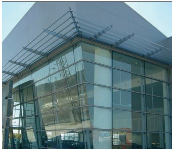
Figura 2. Sistema di schermatura esterna realizzato con aggetto orizzontale di tipo fisso ed elementi frangisole a pale, funzionale alla protezione solare delle superfici dell'involucro edilizio, completamente realizzate in vetro. L'aggetto fisso, di m 1,50 è supportato da mensole in acciaio; le pale sono realizzate in varie dimensioni, variabili da 220 a 470 mm di larghezza. (Pensilina concessionario Volkswagen realizzata dalla Merlo s.r.l.; immagine tratta per gentile concessione dell'azienda dal sito www.merlosrl.com ).
