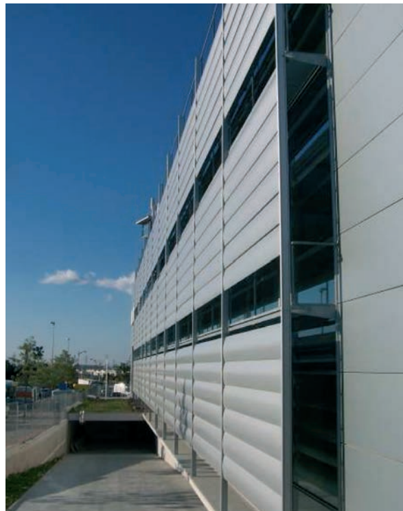
Figure 8 e 9. Sistema di schermatura esterna mobile a schermo verticale (tipologia 1) con pale orizzontali in posizione di schermatura parziale (Figura 1 a sinistra) e di schermatura totale (Figura 2 a destra). (Jefatura Provincial de Trafico de Málaga; arch. Benito Jimenez Gonzalez; realizzazione del sistema di schermatura esterna: Merlo s.r.l.; immagine tratta dal sito www.merlosrl.com per gentile concessione dell'azienda Merlo s.r.l.).
