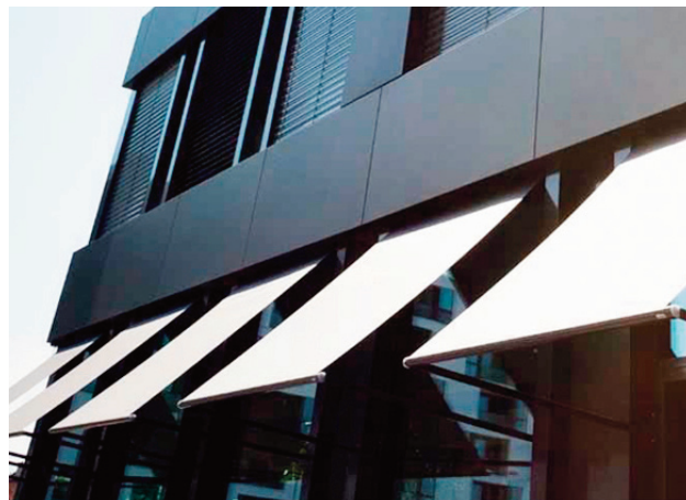
Figura 16. Schermatura solare a superficie continua (tipologia 3) realizzata con tende esterne in tessuto acrilico e tessuto reticolato, con braccio di sporgenza regolabile, prodotte dalla Griesser. (Immagine tratta dal sito: www.edilportale.com ).
