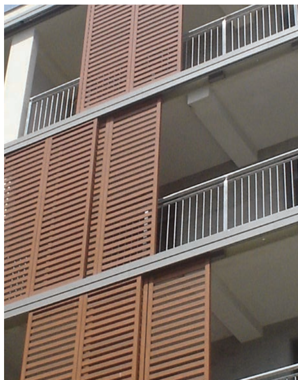
Figura 11. Sistema di protezione solare esterna a schermi verticali (tipologia 2) costituiti da pannelli scorrevoli in legno. Un binario metallico montato al filo esterno della facciata consente lo scorrimento dei pannelli e l'ombreggiamento dei balconi nonché delle aperture vetrate collocate nella parete di fondo.
