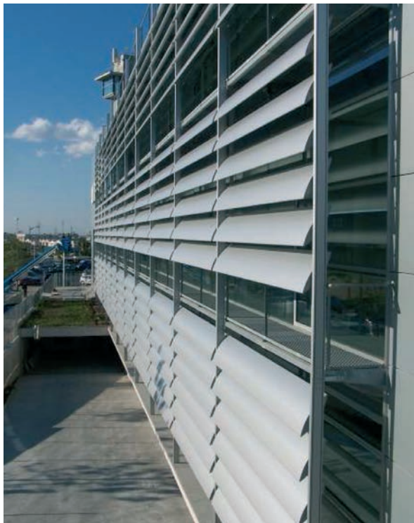
Figure 8 e 9. Sistema di schermatura esterna mobile a schermo verticale (tipologia 1) con pale orizzontali in posizione di schermatura parziale (Figura 1 a sinistra) e di schermatura totale (Figura 2 a destra). (Jefatura Provincial de Trafico de Málaga; arch. Benito Jimenez Gonzalez; realizzazione del sistema di schermatura esterna: Merlo s.r.l.; immagine tratta dal sito www.merlosrl.com per gentile concessione dell'azienda Merlo s.r.l.).
