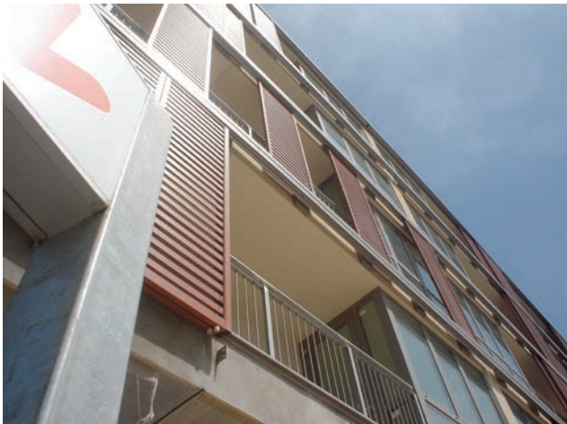
Figura 12. Sistema di protezione solare esterna a schermi verticali costituiti da pannelli scorrevoli in legno. È visibile il binario montato sul filo esterno della facciata ed ancorato al bordo esterno delle solette dei balconi, che consente lo scorrimento dei pannelli.
