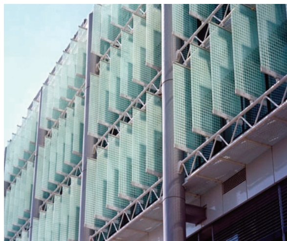
Figura 10. Sistema di schermatura esterna mobile a pale verticali (tipologia 2), funzionale ad intercettare la radiazione solare nelle ore del mattino e quindi correlato all'esposizione est. (Sede centrale Avax S.A., Atene; immagine tratta dal sito https://goo.gl/24sFz0 ).
