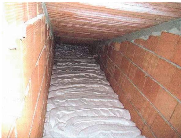
Figura 17. Insufflaggio di volumi confinati: intercapedine di una struttura muraria isolata attraverso insufflaggio di schiuma poliuretanica (immagine tratta da G. Sardella, *Manuale dell'insufflaggio*, Legislazione Tecnica, Roma 2015).
