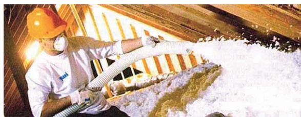
*Figura 16. Realizzazione di isolamento termico di un solaio orizzontale relativo ad un ambiente sottotetto, per insufflaggio del materiale isolante (immagine tratta da G. Sardella, Manuale dell'insufflaggio, Legislazione Tecnica, Roma 2015).*
