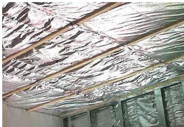
*Figura 13. Soluzione tecnica di isolamento termico di un soffitto con isolante ultrasottile multiriflettente. È visibile la sottostruttura, in listelli di legno, preposta a distanziare in maniera opportuna la controsoffittatura, realizzabile ad esempio in pannelli di cartongesso, dalla superficie dell'isolante.*
