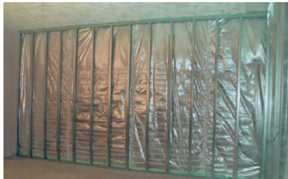
*Figura 12. Soluzione tecnica di isolamento termico di una parete con isolante ultrasottile multiriflettente. È visibile la sottostruttura metallica, preposta a distanziare opportunamente il paramento interno dalla superficie isolante.*
