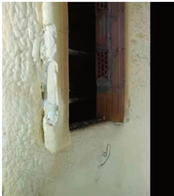
Figura 18. Insufflaggio di una superficie muraria con schiuma poliuretanica. Successivamente sarà realizzata la nuova "fodera" interna.
