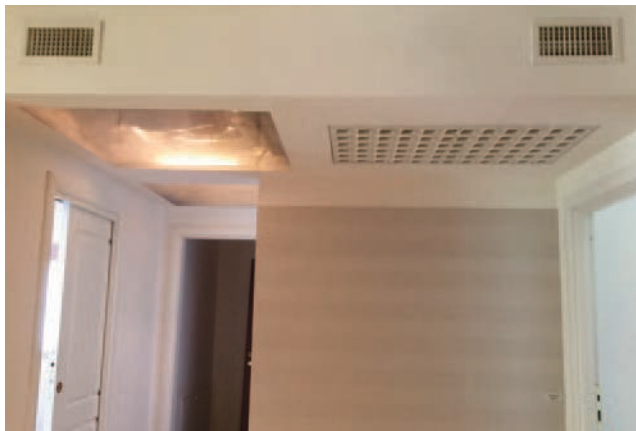
Figura 9. Controsoffittatura di un appartamento per la realizzazione di un impianto di ventilazione meccanica controllata. È visibile il vano per l'alloggio della Macchina VMC con con il pannello di chiusura rimosso. (Appartamento in classe A di un edificio costruito dall'Azienda ImpreMe S.p.a. a Roma)..
