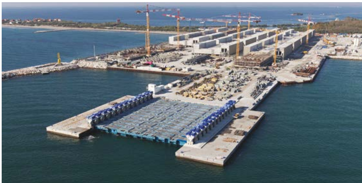
Fig. 1 | Il cantiere di prefabbricazione dove sono stati costruiti e varati i 18 cassoni delle Bocche di Lido e Malamocco, con il Syncrolift in primo piano
