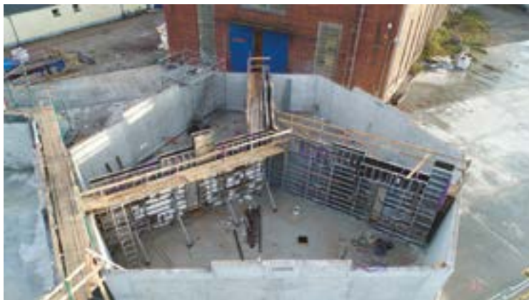
Fig. 33 | Costruzione pareti interne in c.a. dello scafo.
