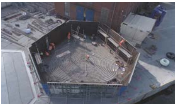
Fig. 32 | Costruzione scafo in calcestruzzo armato.
