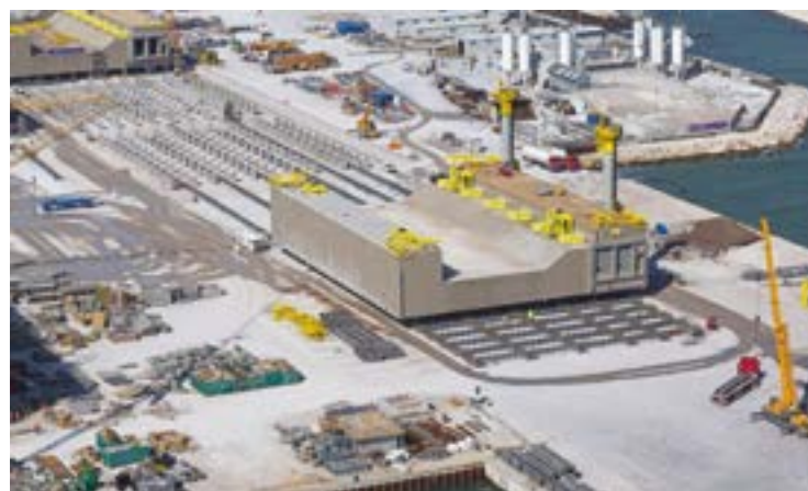
Fig. 1 | Cassone di fondazione con montato telaio porta giunti tipo GINA
