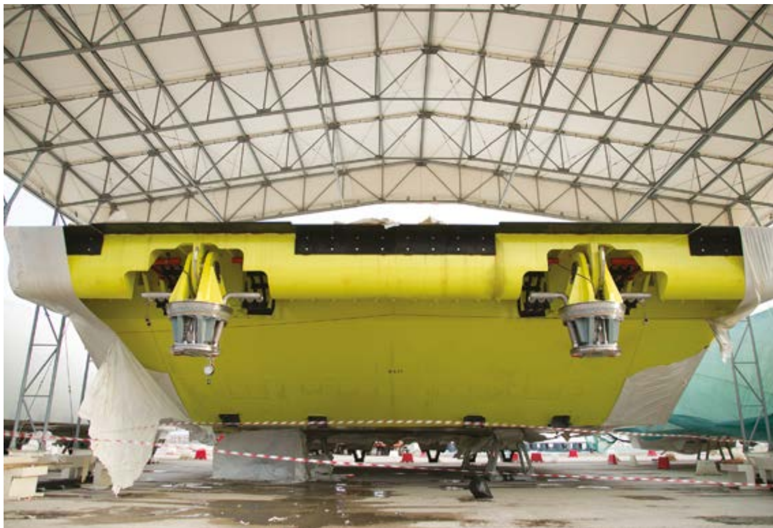
Fig. 10 | Paratoia con cerniere montate
