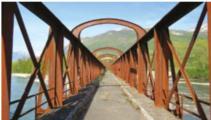
Fig. 10 | Ponte a Cruet: vista della travata reticolare continua (ACN&P).
