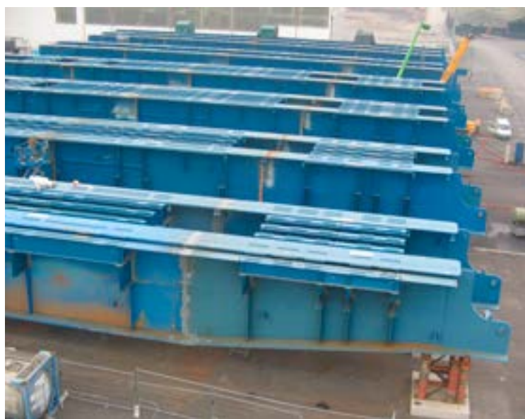
Fig. 3 | Il cantiere di allestimento delle travi del Syncrolift a Marghera
