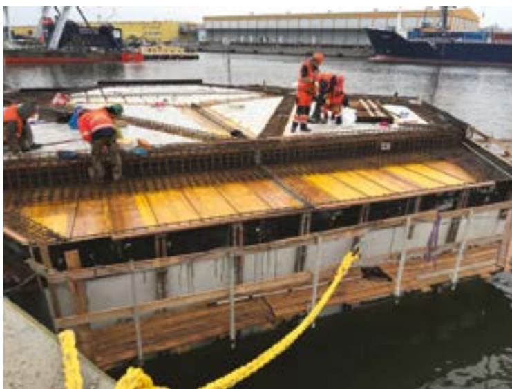
Fig. 35 | Costruzione ponte superiore dello scafo.
