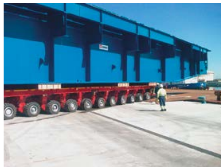
Fig. 6 | Carico delle travi principali del Syncrolift sulla chiatta di trasporto
