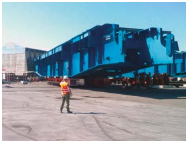
Fig. 5 | Le travi principali del Syncrolift durante il trasferimento dal cantiere di assemblaggio di Marghera al pontone per il trasporto alla Bocca di Malamocco
