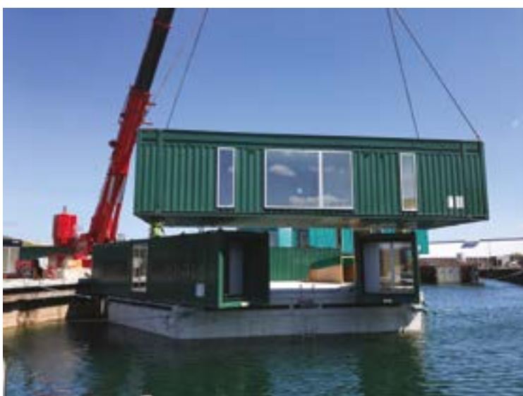
Fig. 41 | Assemblaggio container sovrapposti.
