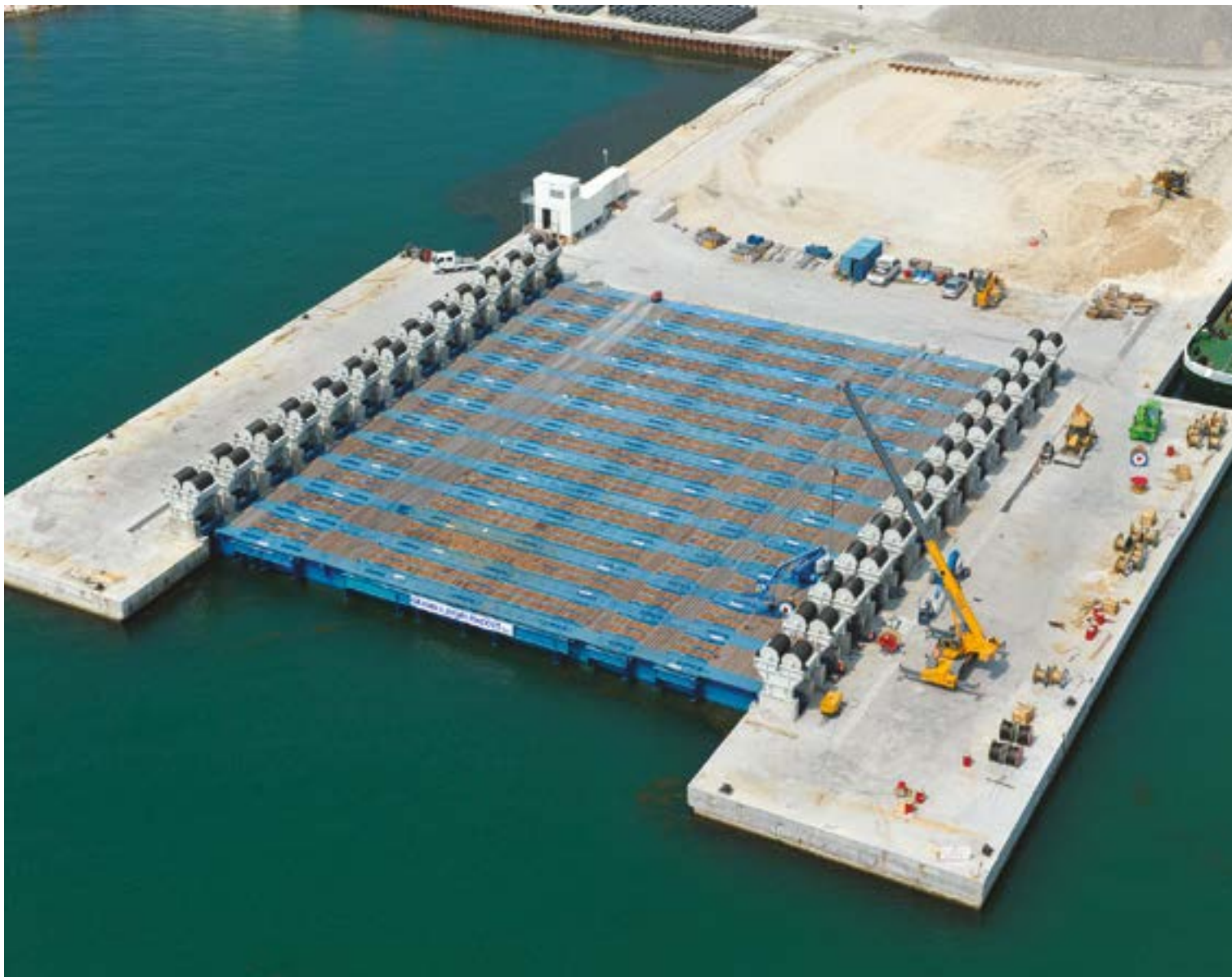
Fig. 7 | La piattaforma del Syncrolift in fase di completamento
