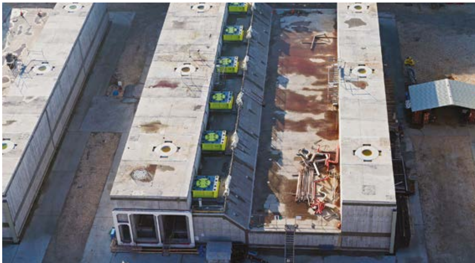
Fig. 6 | Tipico cassone con elementi “femmina” montati
