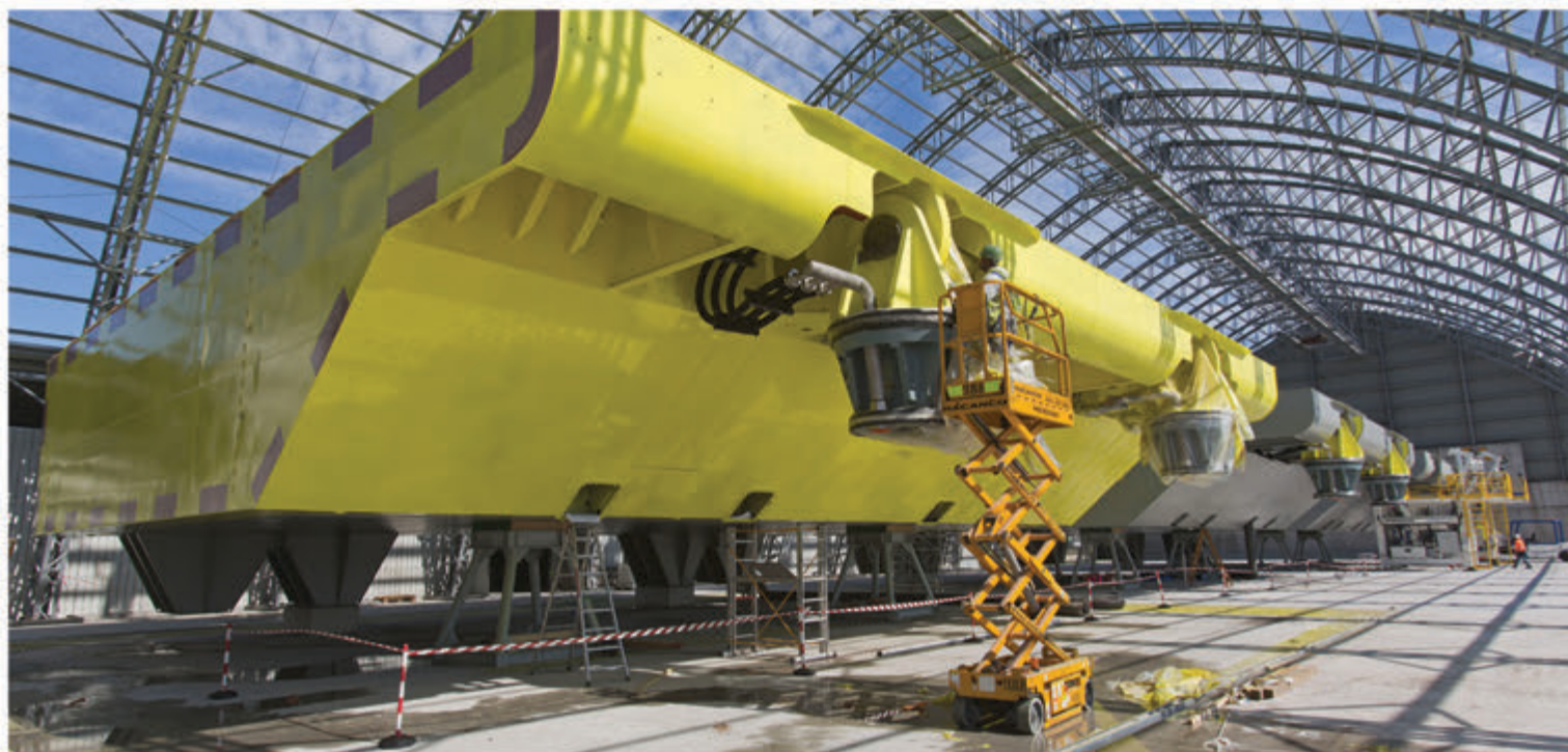
Fig. 10 - Montaggio dell'elemento "maschio" sulla paratoia
