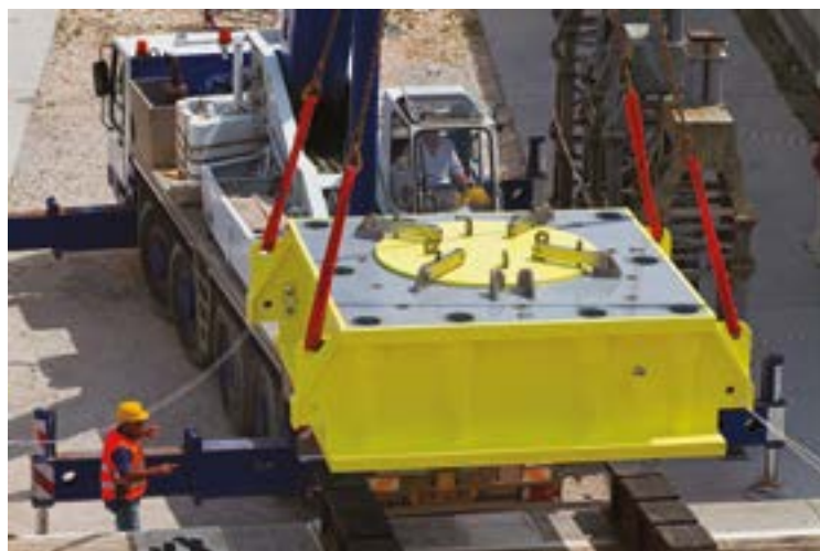
Fig. 4 | Trasporto e montaggio elemento “femmina” su cassone
