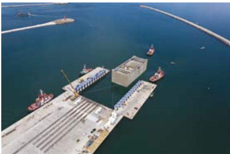
Fig. 10 | Estrazione di un cassone in galleggiamento dal bacino del Syncrolift
