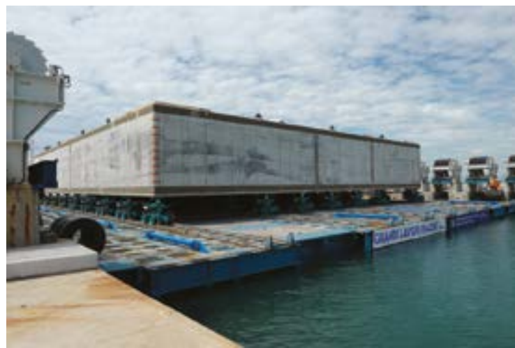
Fig. 9 | Varo di un cassone in c.a. con il sistema Syncrolift(R)
