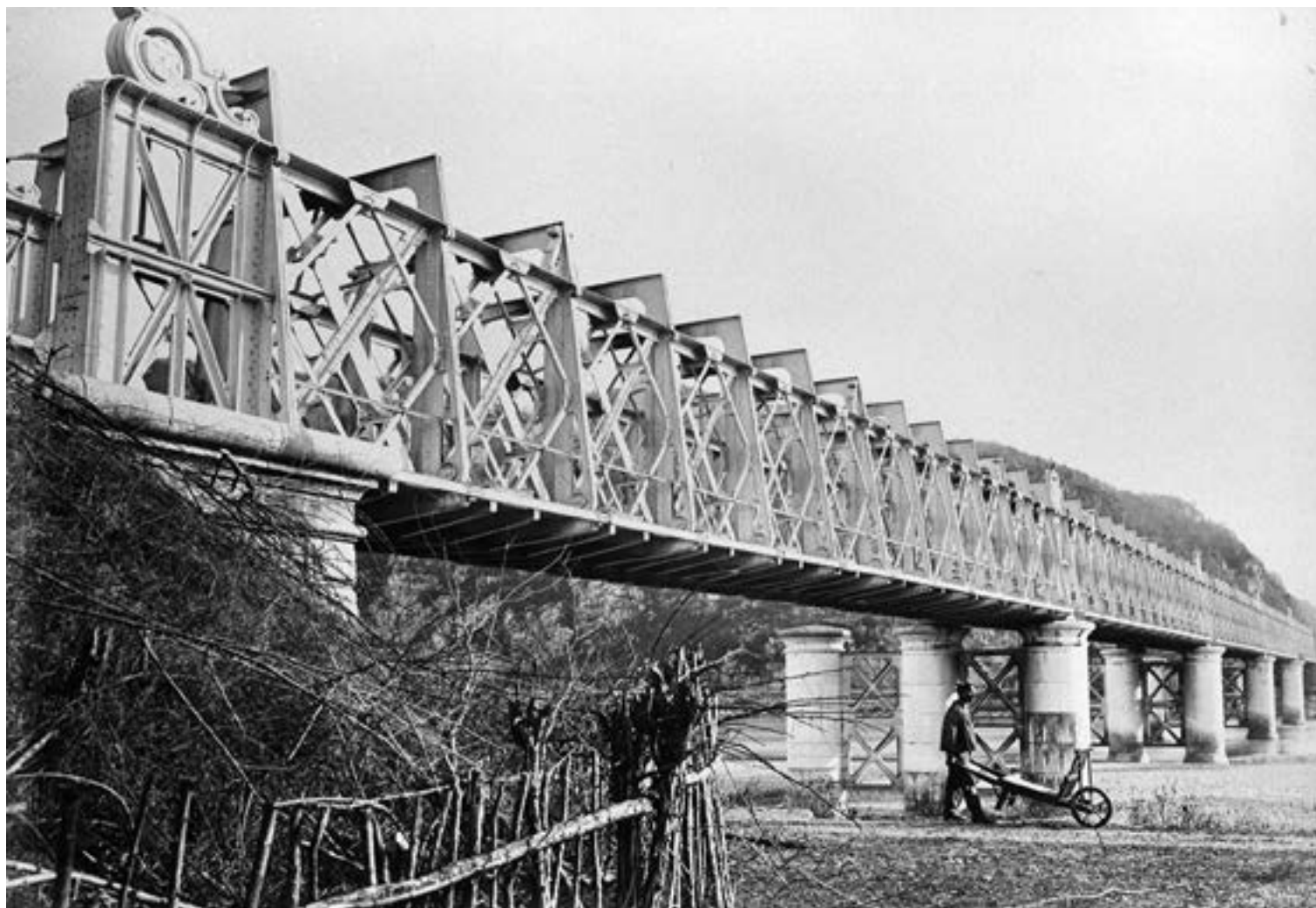
Fig. 14 | Ponte a Culoz: vista dei tubi in ghisa a tutt'altezza e delle travature reticolari (Ministère des travaux publics, 1873).
