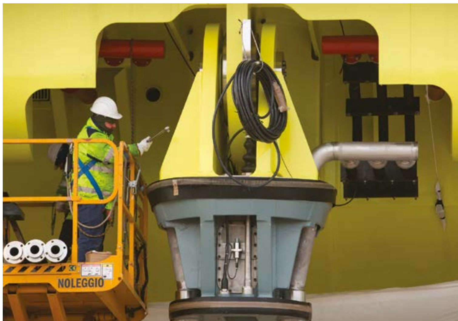
Fig. 1 | Montaggio dell'elemento "maschio" sulla paratoia
