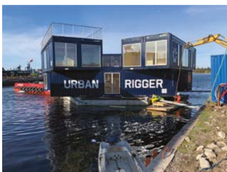
Fig. 44 | Installazione sistemi di ancoraggio alla terraferma.
