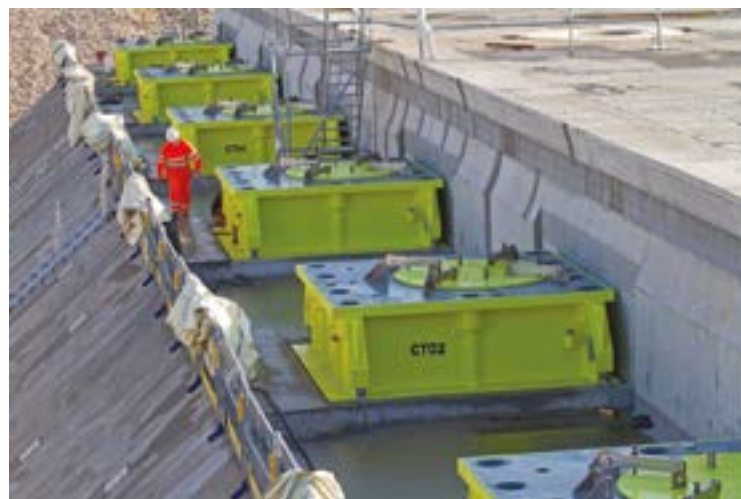
Fig. 5 | Montaggio in opera dell'elemento “femmina” sui cassoni
