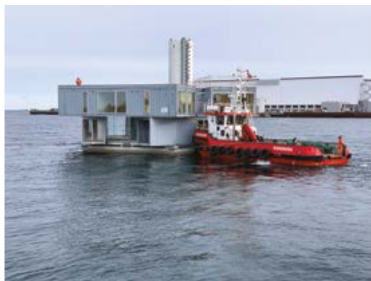
Fig. 43 | Trasporto nuclei abitativi via mare al sito finale di progetto.
