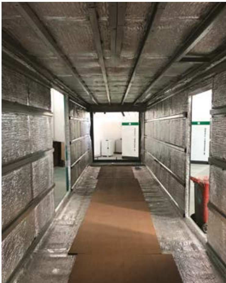
Fig. 31 | Vista guscio interno container in isolante riflettente.
