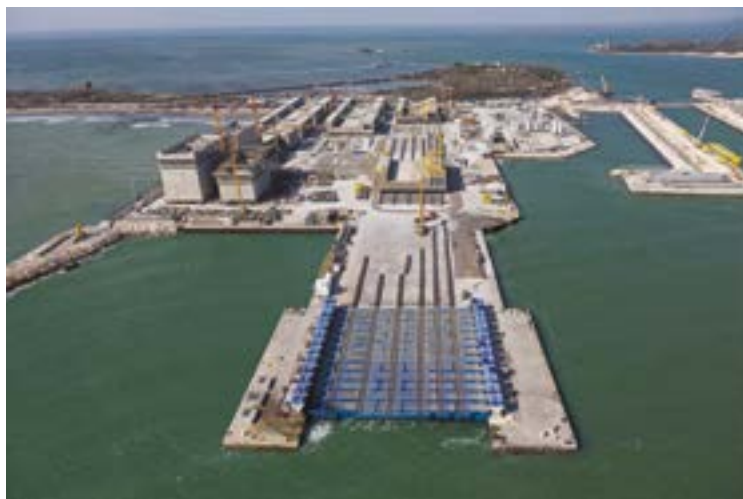
Fig. 8 | La Mega piattaforma Syncrolift per il varo dei cassoni prefabbricati
