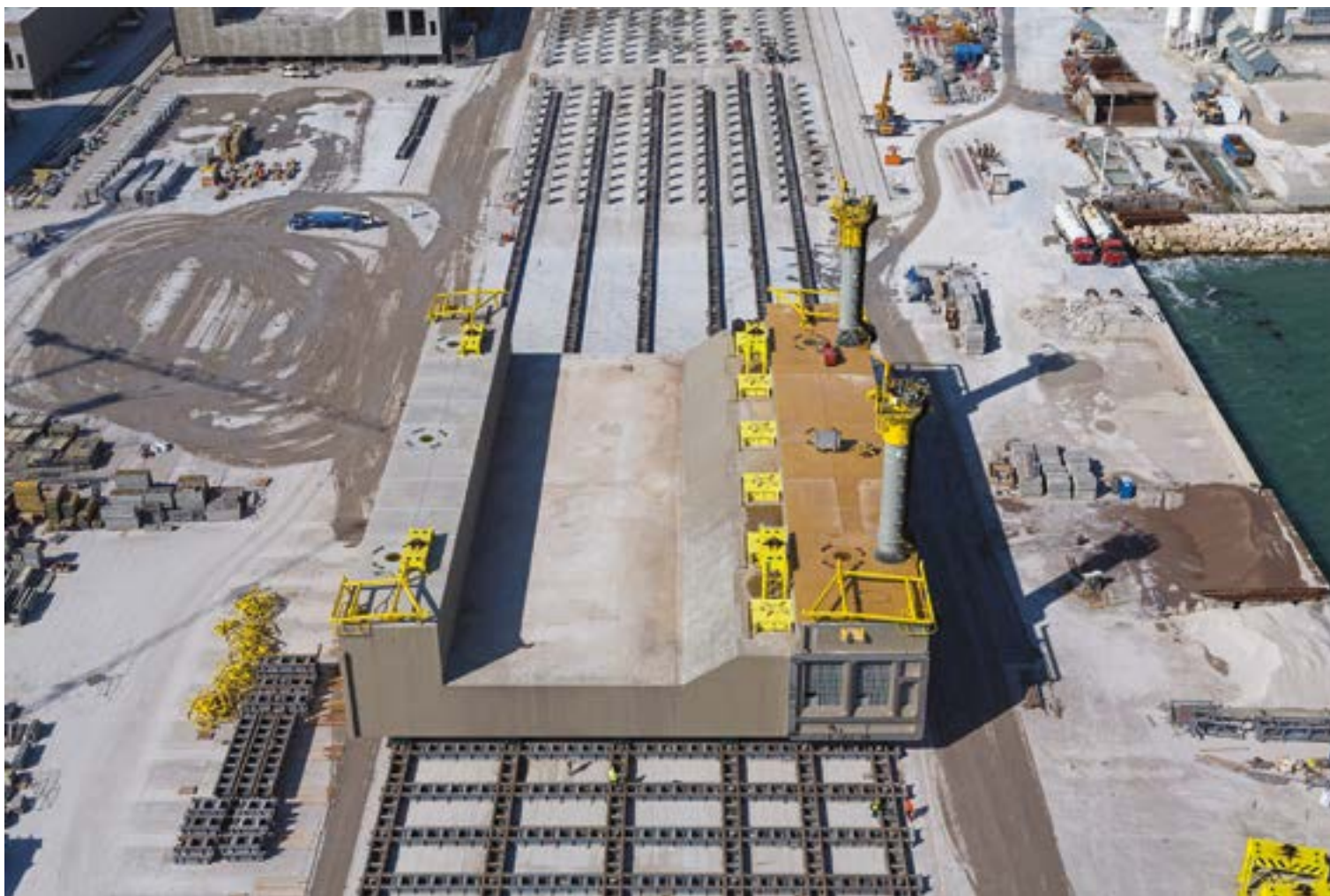
Fig. 2 | Uno dei cassoni di soglia pronto per il varo e già allestito con tutti gli accessori e parte degli impianti
