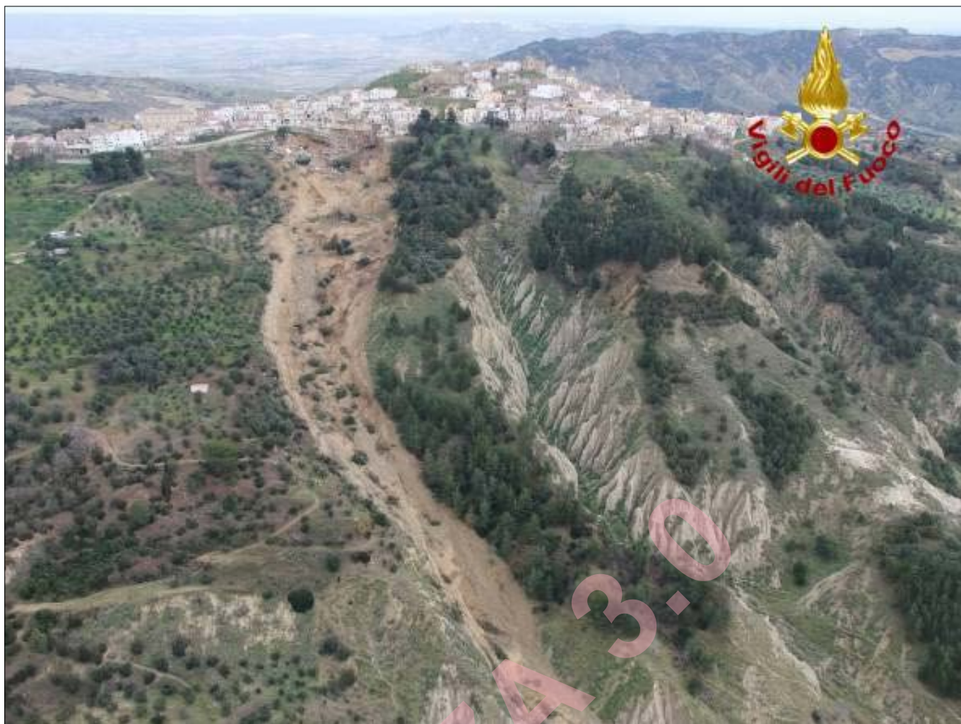
Figura 4. Fronte della frana 29 gennaio 2019
