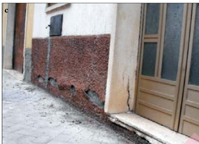
Figura 4. Esempi dei danni da frana osservati nel centro abitato di Celenza Valfortore: a) lesioni capillari, grado 1; b) spostamento tra parti di giunzione, grado 3; c) rigonfiamento e lesioni alla base di edificio, grado 4; d) rottura di cordolo, grado 5
