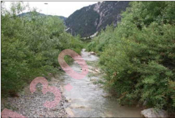
Fiume Fella, post operam, giugno 2013. Foto Sauli
