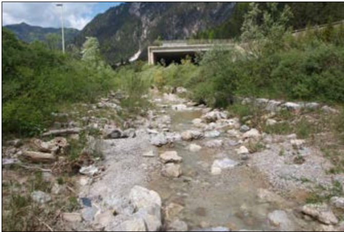
Fiume Fella, post operam, maggio 2011
