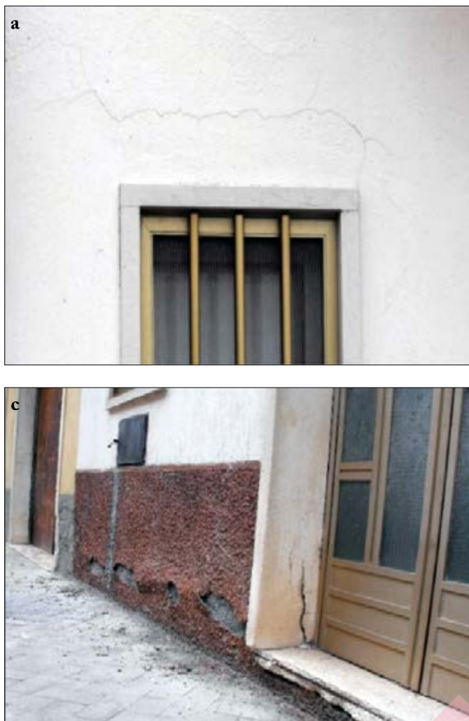
Figura 4. Esempi dei danni da frana osservati nel centro abitato di Celenza Valfortore: a) lesioni capillari, grado 1; b) spostamento tra parti di giunzione, grado 3; c) rigonfiamento e lesioni alla base di edificio, grado 4; d) rottura di cordolo, grado 5
