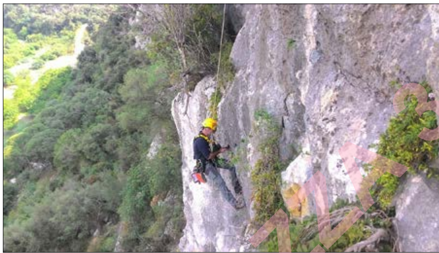
Figura 5. Fasi esecutive dei rilievi geostrutturali e geomeccanici
