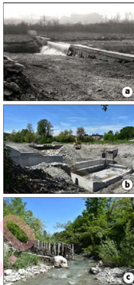
Figura 9. Una briglia realizzata sul Torrente Tiepido (a) nel 1979 (la terza di figura 3) e (b) la ricostruzione dell'ultima della serie crollata nel 2019. Un tentativo di ingegneria naturalistica, (c) dove sono stato utilizzati materiali naturali in sostituzione del calcestruzzo, senza tener conto che anche i criteri progettuali dovevano essere diversi, con evidenti risultati negativi
