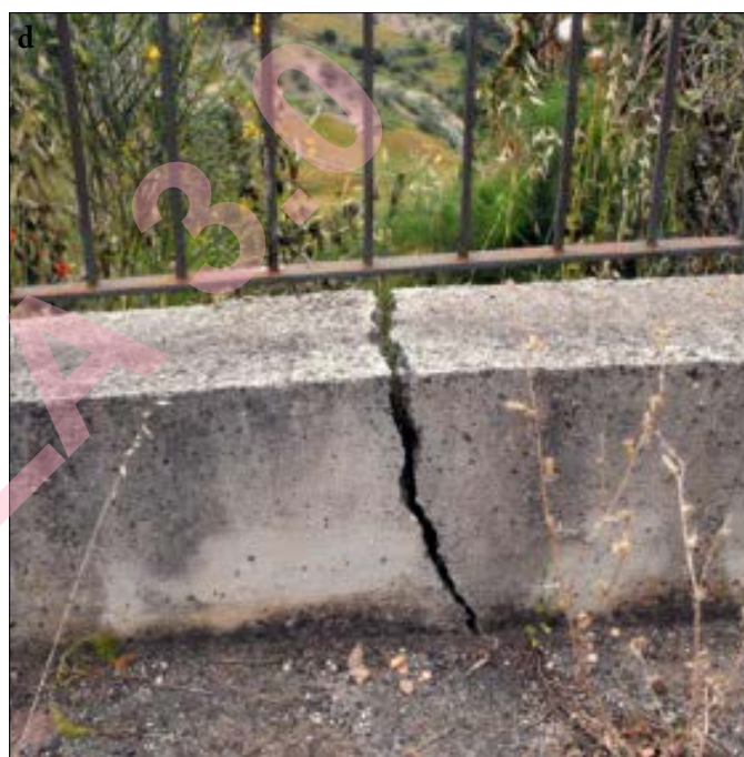
Figura 4. Esempi dei danni da frana osservati nel centro abitato di Celenza Valfortore: a) lesioni capillari, grado 1; b) spostamento tra parti di giunzione, grado 3; c) rigonfiamento e lesioni alla base di edificio, grado 4; d) rottura di cordolo, grado 5
