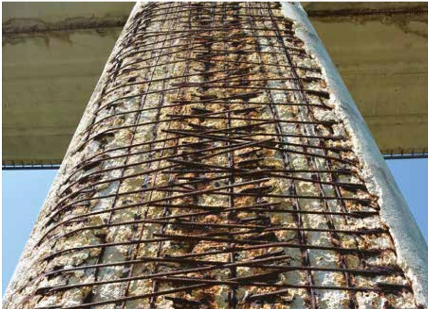
■ Il pesante degrado di una struttura in cemento armato, ormai priva del copriferro
