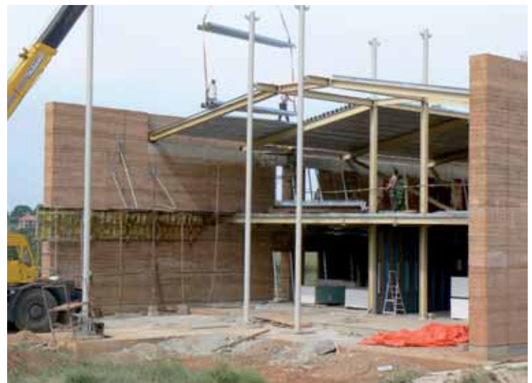
Fig. 32 - Montaggio del solaio di copertura dell'ala nord. © Emergency NGO Technical Department
