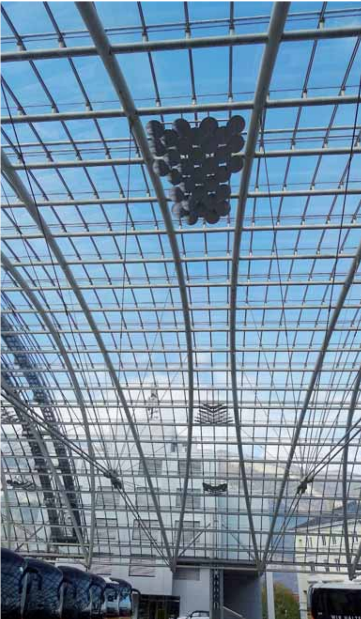
Fig. 13 - Stazione degli Auto-postali di Coira Vista d'insieme degli spicchi - all'estradosso si noti la passerella per la pulizia
