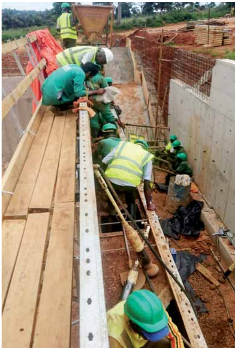
Fig.20 – Costruzione delle murature in pisé. © Massimiliano Milan
