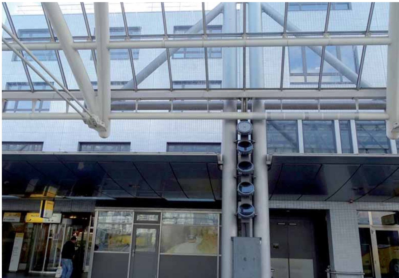
Fig. 14 – Stazione degli Auto-postali di Coira – Colonne principali di sostegno
