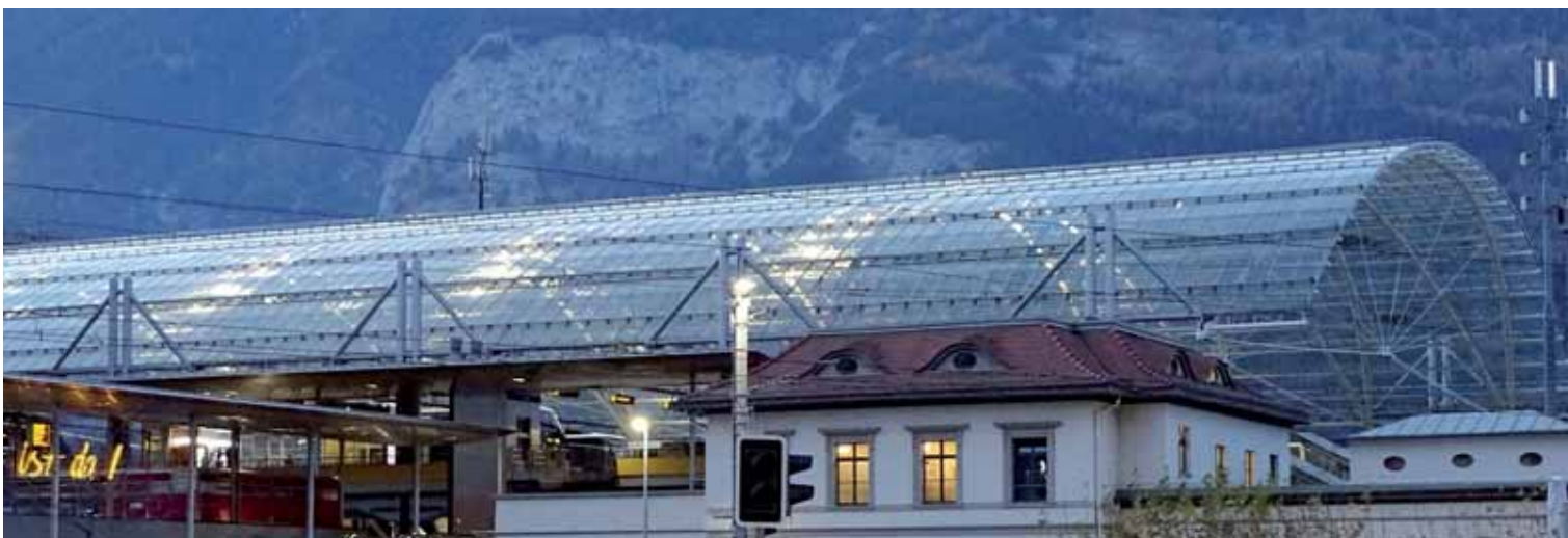
Fig. 17 – Stazione degli Auto-postali di Coira – Vista di insieme della copertura
