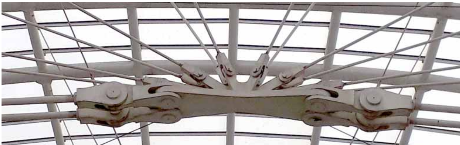
Fig. 16 – Stazione degli Auto-postali di Coira – Dettaglio centrale per catene e stralli
