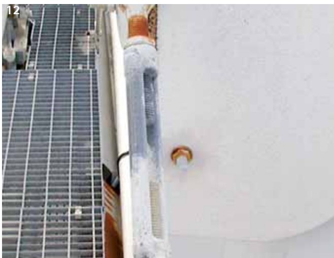
Fig. 11 – Tiranti del telo, ossidati per metà bullone, e indenni da attacchi ossidanti nel restante stelo. Fig. 12 – Dettagli dell'anello di funi centrale con bulloni ossidati. Fig.13 – corda in acciaio, o cavetto, e stelo. La corrosione ha fatto rompere alcuni fili dell'avvolgimento del cavetto. La sezione così ridotta ha ceduto.
