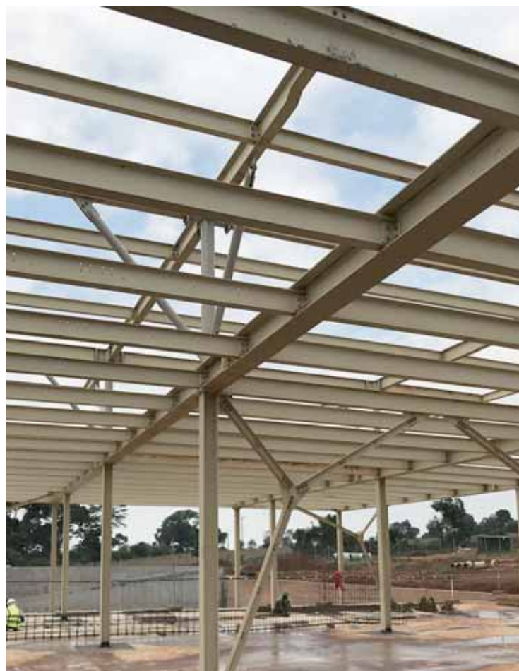
Fig. 46 – Costruzione della struttura di acciaio del corpo centrale. © Emergency NGO Technical Department
