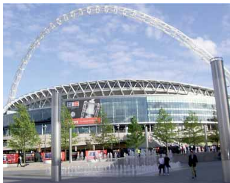
Fig. 14 – Wembley, 90 000 spettatori. L'arco, alto 133 m e lungo 315 m, sorregge la copertura dello stadio.
