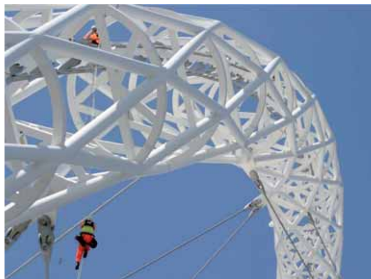
Fig. 15 – l'arco durante la costruzione ha richiesto l'intervento di acrobati. Il monitoraggio dell'arco può usufruire di droni, ma la eventuale manutenzione sarà sempre una difficoltà.
