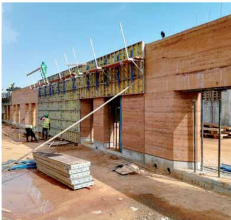
Fig. 21 – Scasseratura delle murature in pisé © Massimiliano Milan
