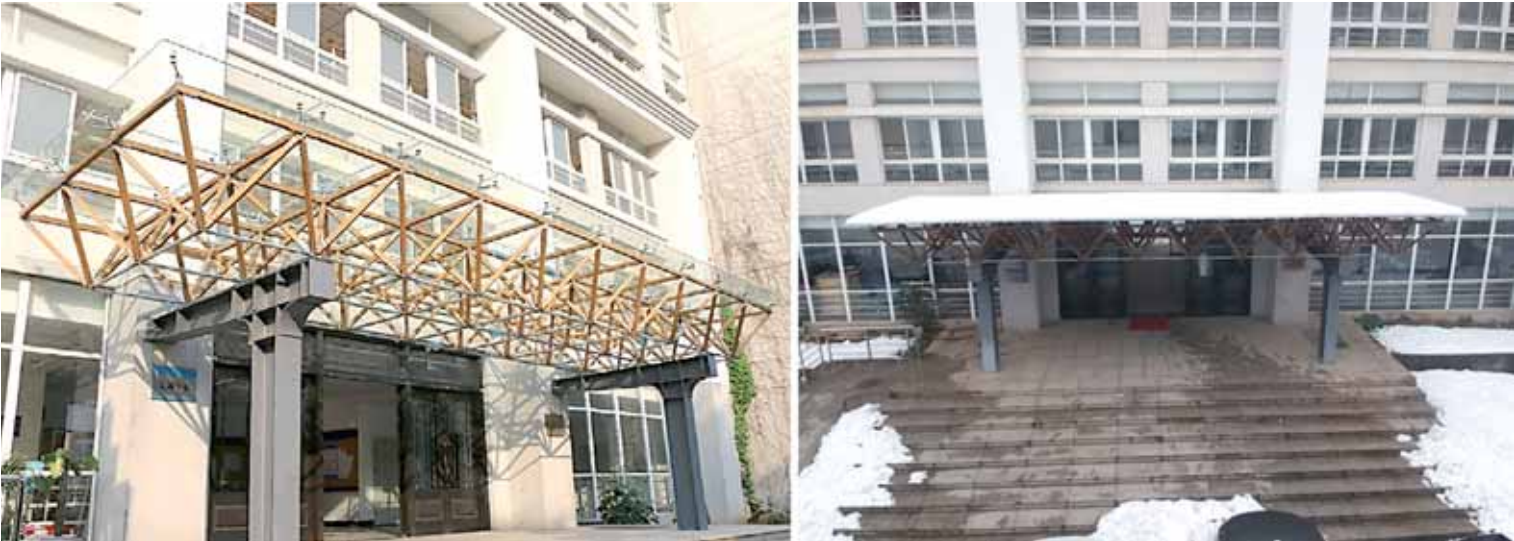
Fig. 11 - Struttura reticolare in glubam e acciaio realizzata a copertura dell'ingresso della facoltà di Ingegneria Civile presso la Nanjing Tech University (China)
