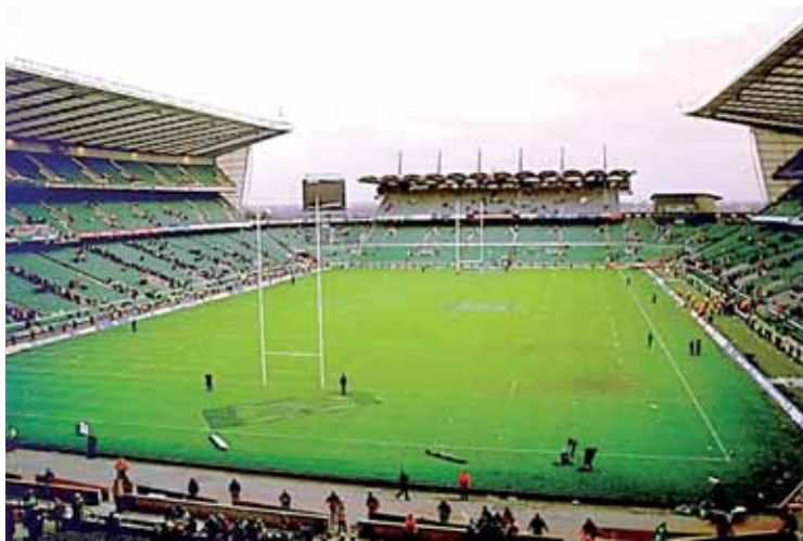
Fig. 1 - Il vecchio Stadio Twickenham, (Richmond upon Thames, sobborgo di Londra), capace di ospitare 75.000 spettatori seduti, disposti su quattro tribune separate tra loro.
