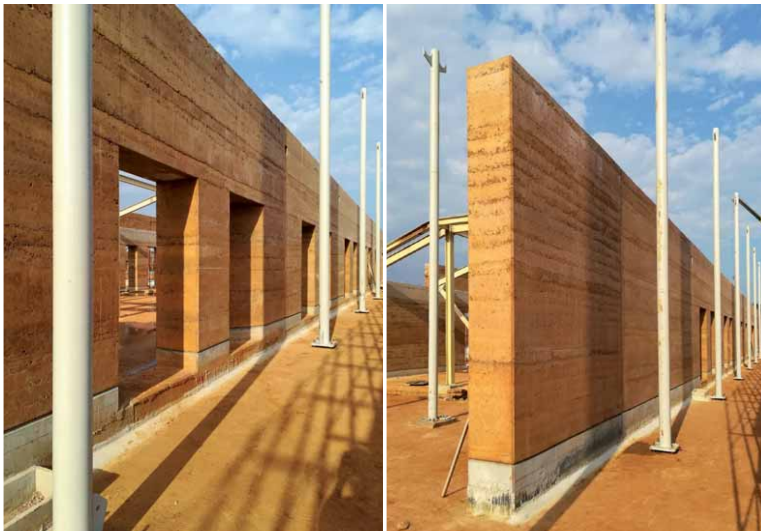
Figg. 24-25 – Scorci delle murature in pisé durante il montaggio delle colonne esterne della struttura di ombreggiamento della copertura dell'ala sud. © Emergency NGO Technical Department
