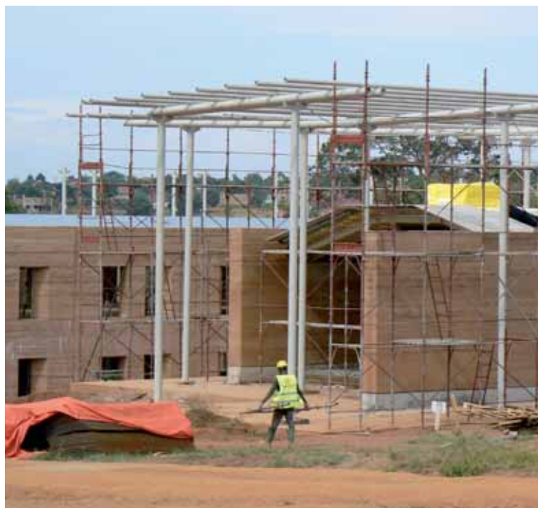
Fig. 43 – Costruzione del sistema di ombreggiamento dell'ala sud in corrispondenza del fronte ovest. © Emergency NGO Technical Department
