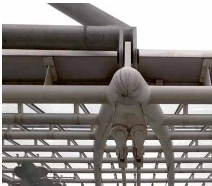
Fig. 15 – Stazione degli Auto-postali di Coira – Dettaglio di appensione degli archi ai montanti principali
