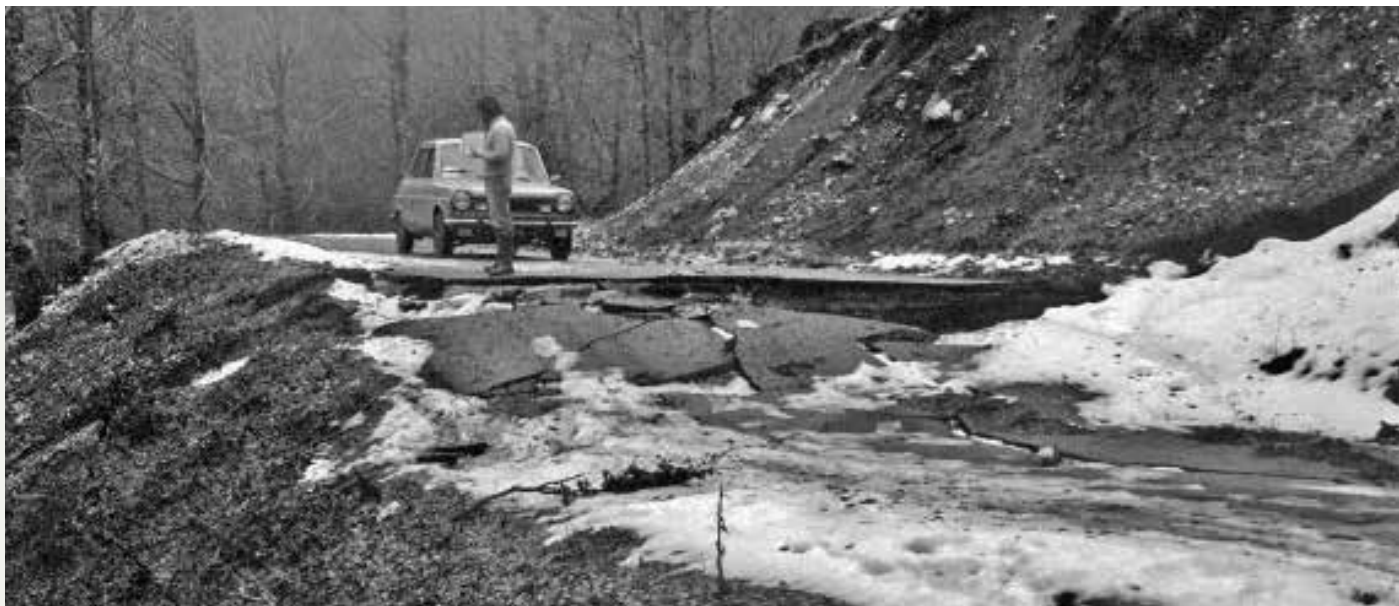
Fig. 2 - Vista della fagliazione di superficie (circa 1 m di rigetto verticale) del terremoto irpino del 1980 lungo la strada che attraversa la località Piano di Pecore (foto del Prof. Italo Sgrosso, in Galli & Peronace, 2014).
