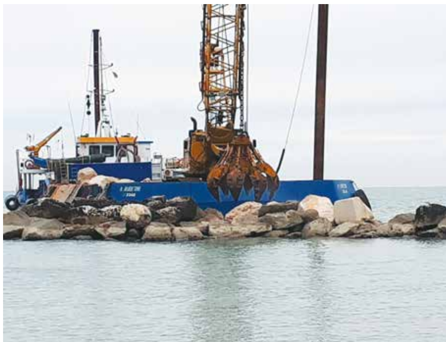
■ Cattolica (Rimini). Lavori di manutenzione e rinforzo della scogliera
