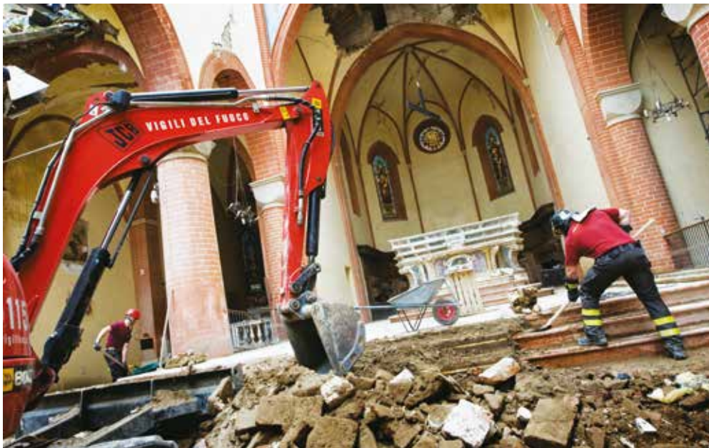
■ Mirandola (Modena). I danni provocati dal violento terremoto del 2012
