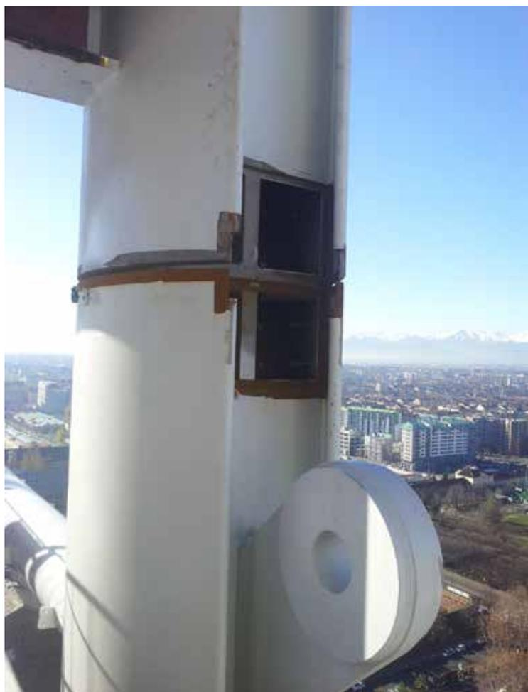
Fig. 10 | Dettaglio collegamento tra conci di megacolonna.
