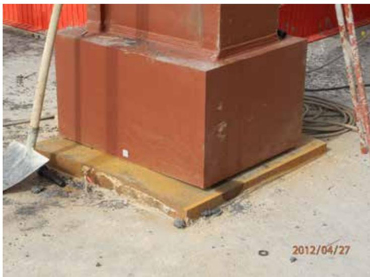
Fig. 12 | Esempio di nodo con elemento fucinato.
