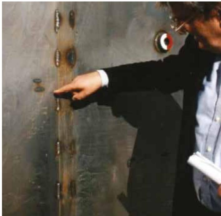
Fig. 5 | Presenza di ossidi di saldatura su una superficie di acciaio inossidabile (omaggio a Pietro Pedeferrì).
