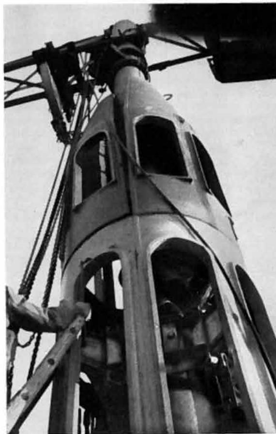
Fig. 9 - Montaggio dei due ultimi settori metallici sottostanti la stella.
