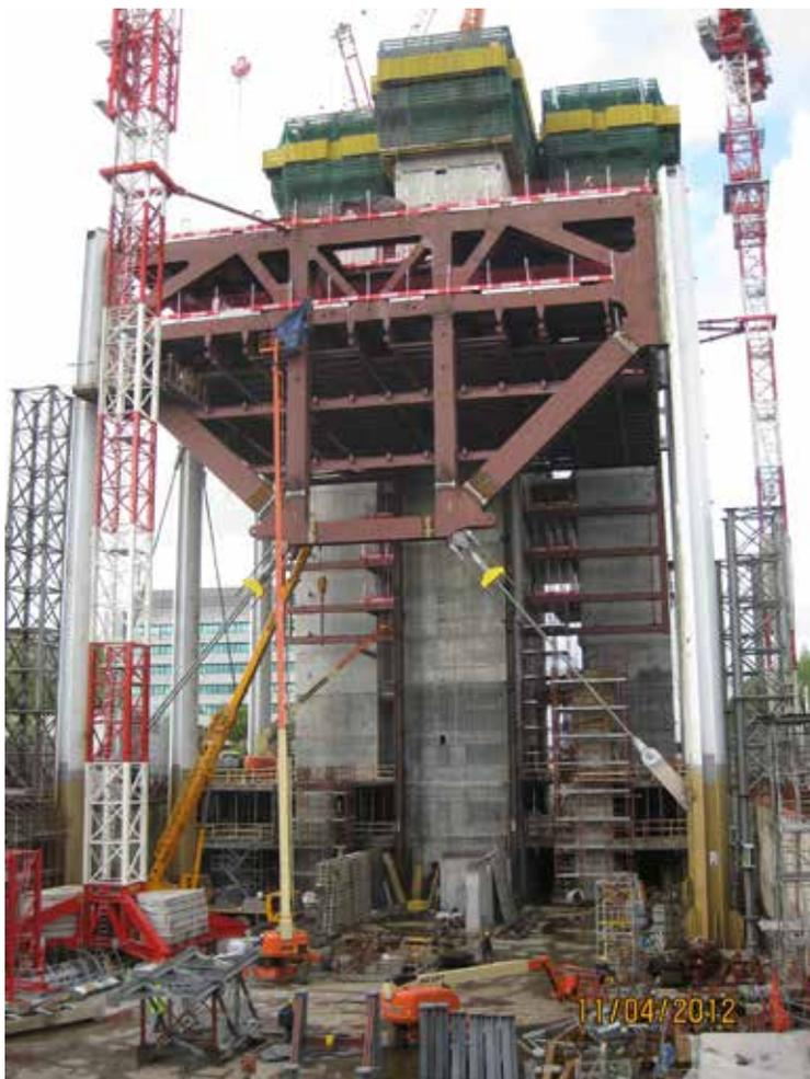
Fig. 8 | Struttura transfer in costruzione.
