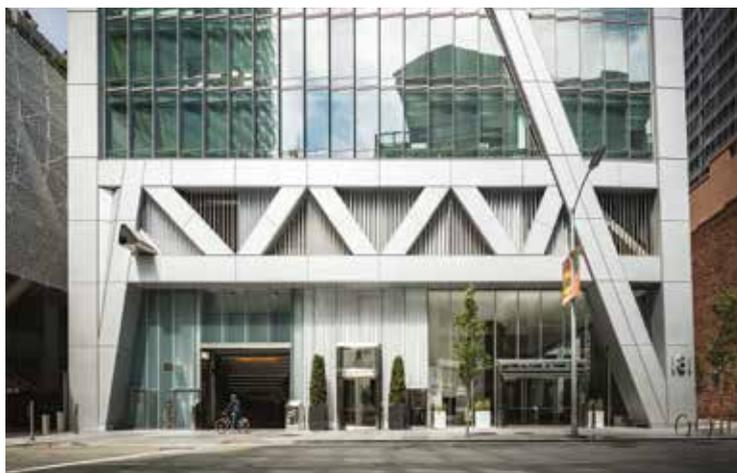
Fig. 15 | Struttura reticolare del secondo piano che garantisce un piano terra privo di pilastri in facciata. © Scott Hargis
