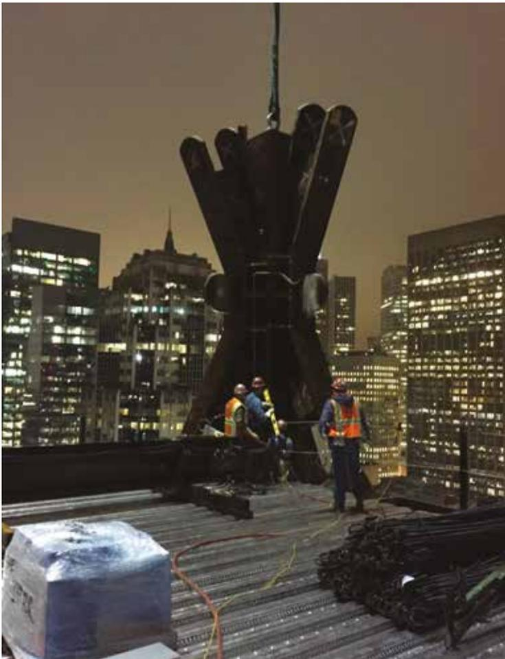
Fig. 18 | Nodo della struttura ad esoscheletro, fase di cantiere.
