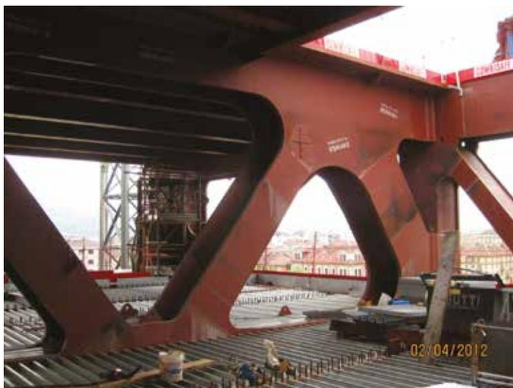
Fig. 6 | Struttura transfer a livello 6.
