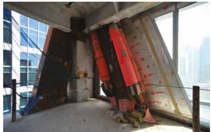
Fig. 21 | Smorzatori viscosi, fase di cantiere. © Heller Manus Architects
