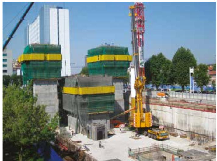
Fig. 3 | Core in fase di costruzione.
