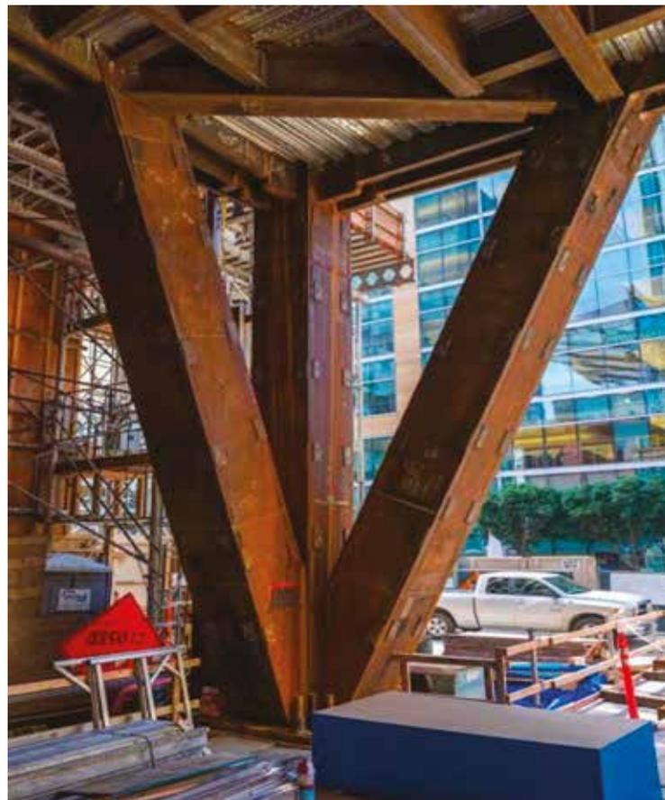
Fig. 17 | Struttura portante in acciaio al piano terra, fase di cantiere. © Heller Manus Architects
