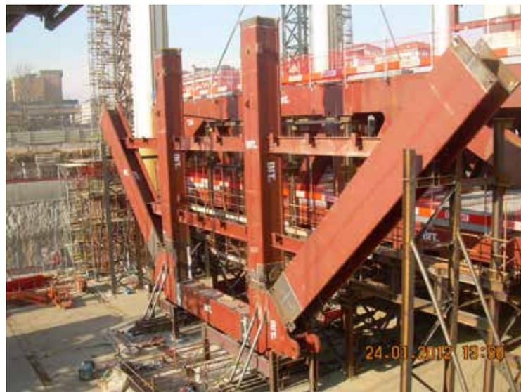
Fig. 7 | Struttura transfer in costruzione.
