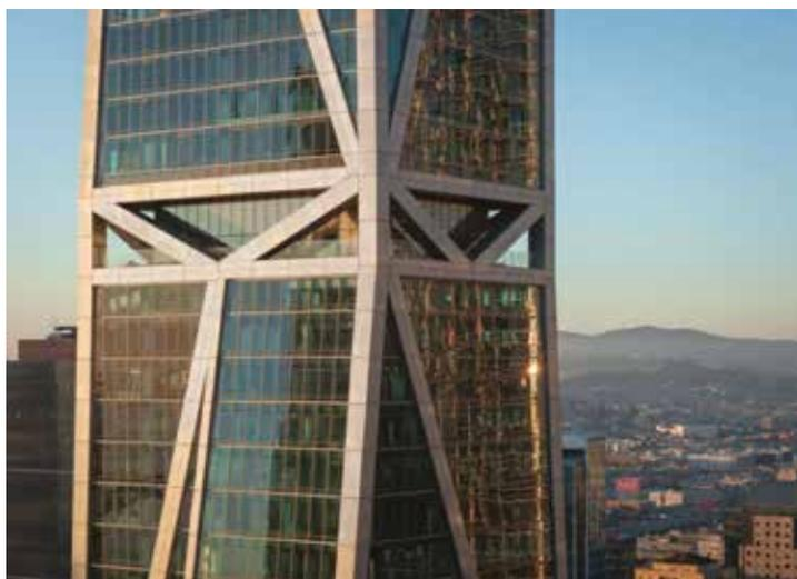
Fig. 16 | Struttura reticolare al 39 piano in corrispondenza dell'amenity floor. © Scott Hargis
