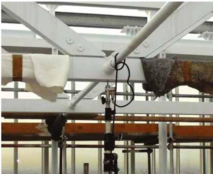
Fig. 8 | Le travi reticolari Warren della copertura della serra, con i nodi formati esclusivamente con perni
