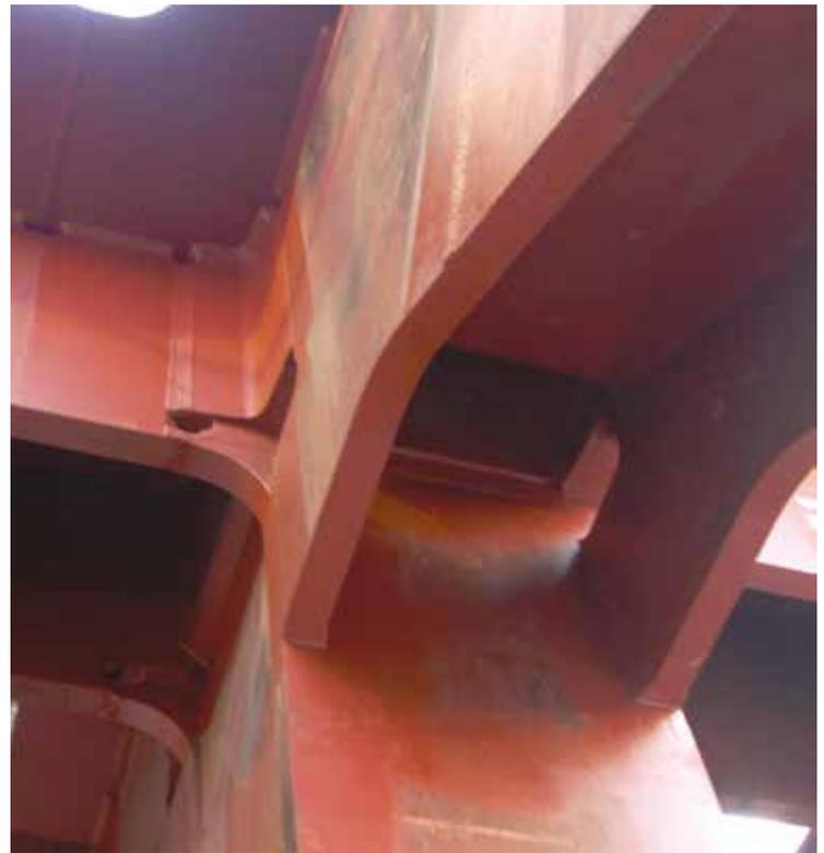
Fig. 4 | Il nodo di intersezione tra i correnti superiori delle travi reticolari trasversali e longitudinali, visto dal basso
