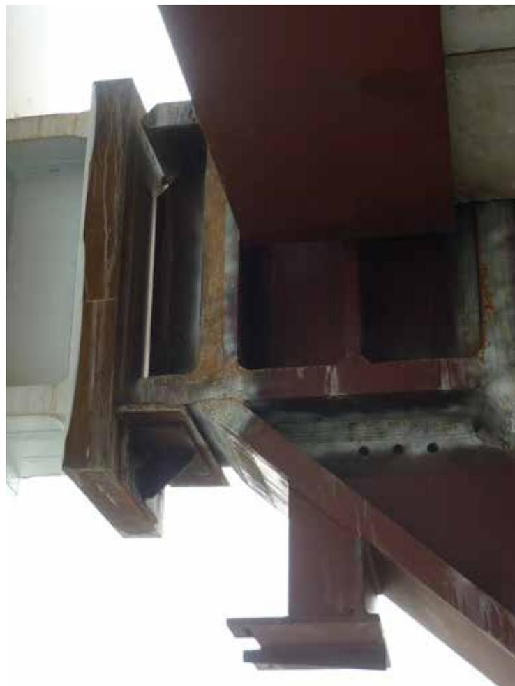
Fig. 14 | Esempio di nodo con saldature a T.
