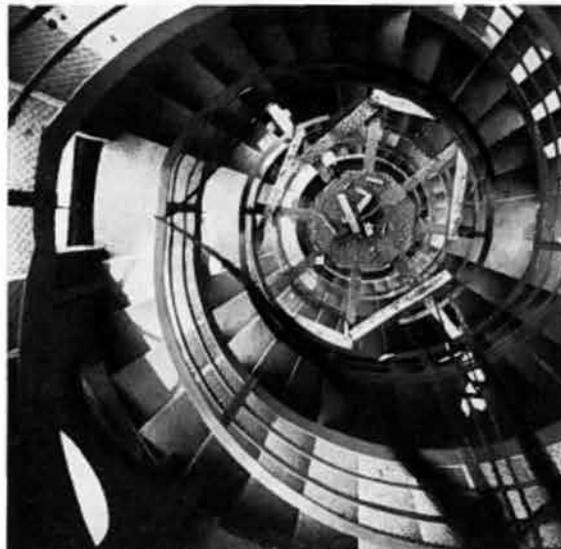
Fig. 12 - Particolare delle nuove scale, rete di protezione e palco per sostegno ponteggio esterno.
