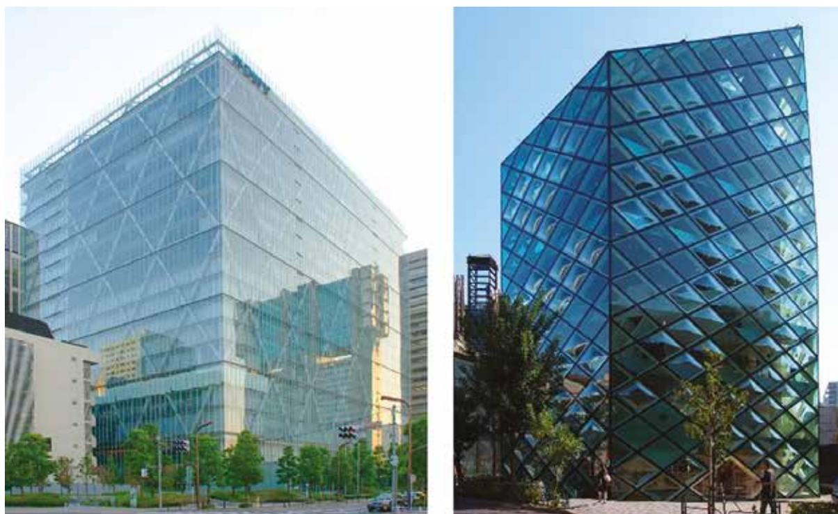
Fig. 3. | Edifici diagrid con isolamento sismico alla base, da sinistra: Sony City (Tokyo), Prada Boutique Aoyama (Tokyo).
