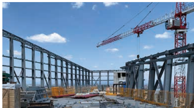
Fig. 21 | Foto della struttura metallica della vela – lato verso Nord-Est.
