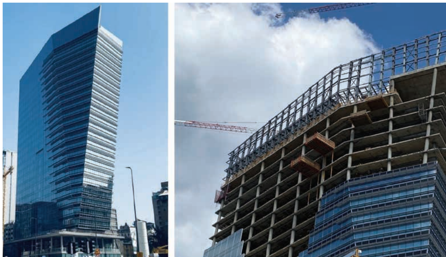
Fig. 1 | Vista di torre Gioia 22 dall'incrocio tra via Melchiorre Gioia e via Pirelli.
