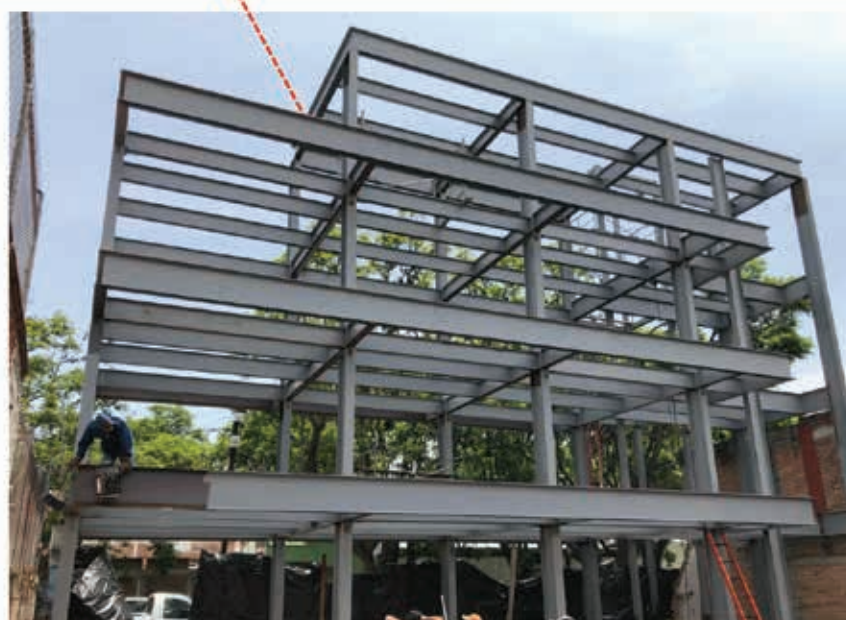
Fig. 15 | Struttura di elevazione verticale (pilastri) ed orizzontale (travi) del Centro dermatológico Avenida Central Building (fonte: Emilio Alvarez Abouchard Arquitectura)
