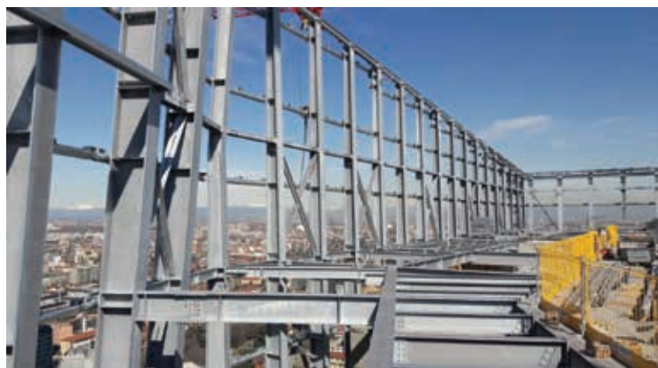
Fig. 20 | Foto della struttura metallica della vela – lato verso Nord.
