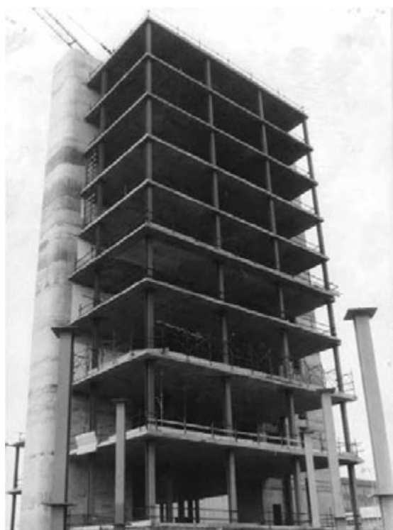
Fig. 18 | Edificio più alto
