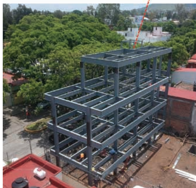
Fig. 15 | Struttura di elevazione verticale (pilastri) ed orizzontale (travi) del Centro dermatológico Avenida Central Building (fonte: Emilio Alvarez Abouchard Arquitectura)
