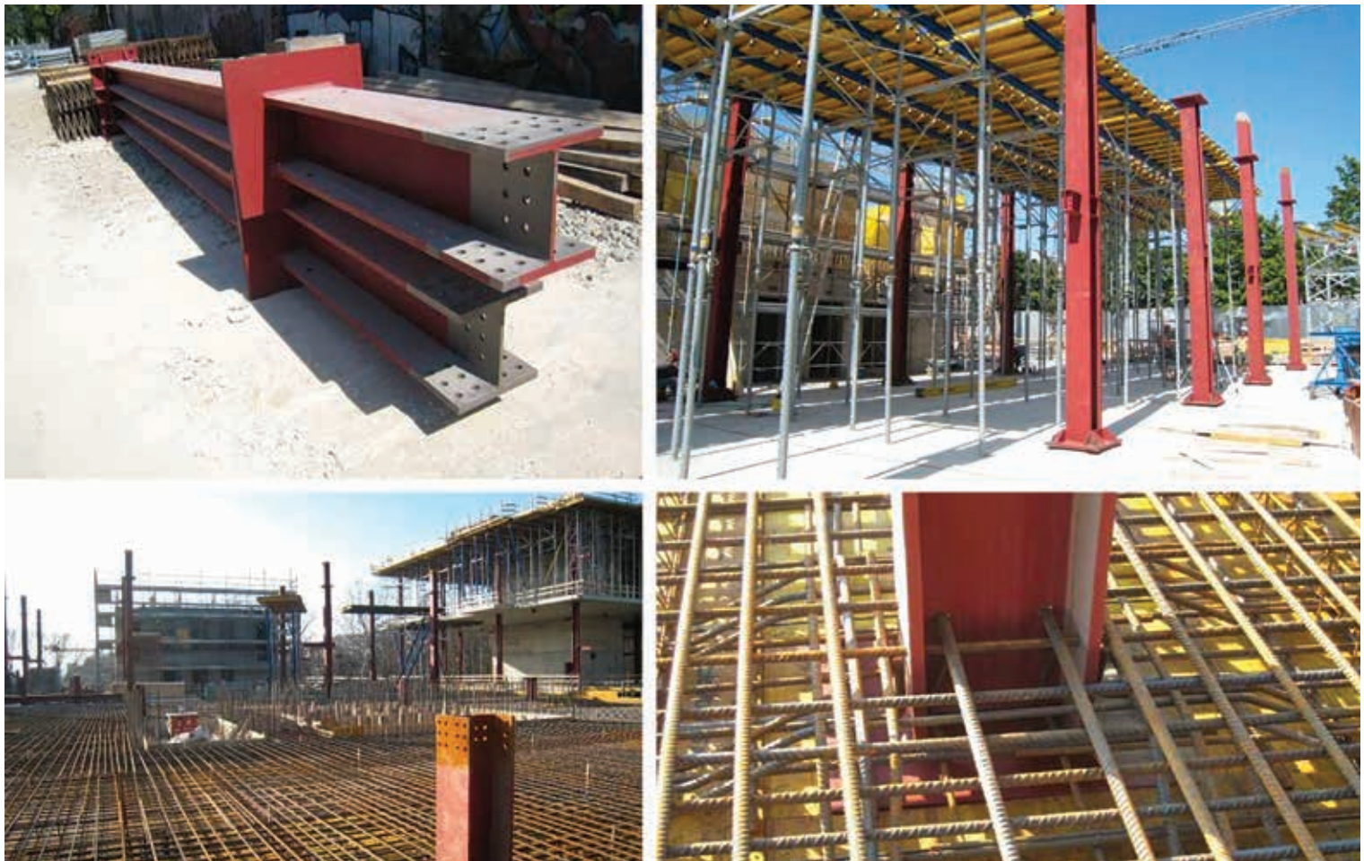
Fig. 28 – Edifici di via Tortona 37, Milano – Dettagli strutturali
