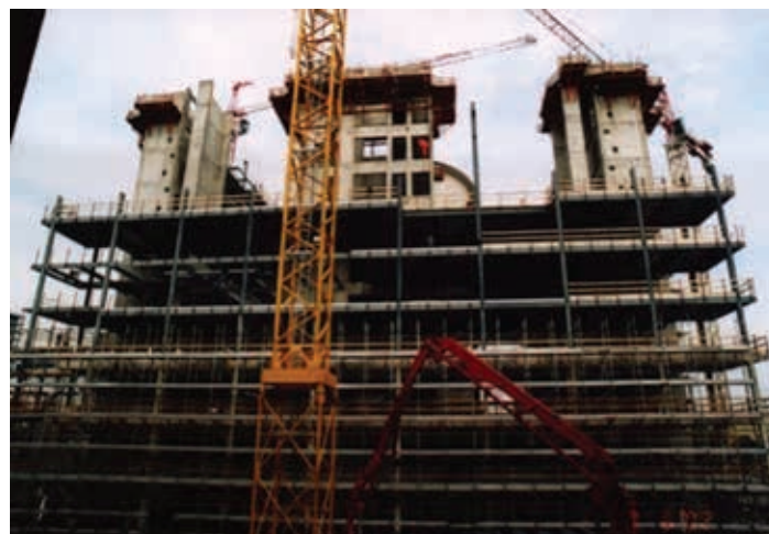
Fig. 2 | Pirelli Headquarter – Milano, in costruzione
