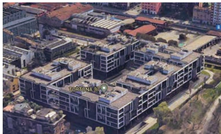
Fig. 25 | Edifici di via Tortona 37, Milano – Vista d'insieme
