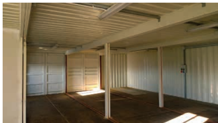
Fig. 7 | Centro del riuso di Montecassiano - Vista interna
