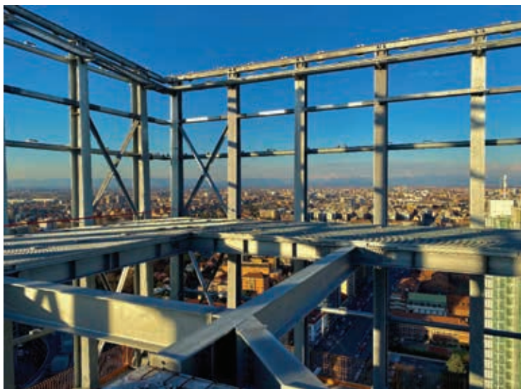
Fig. 15 | Montaggio della struttura, fasi 1 e 2.
