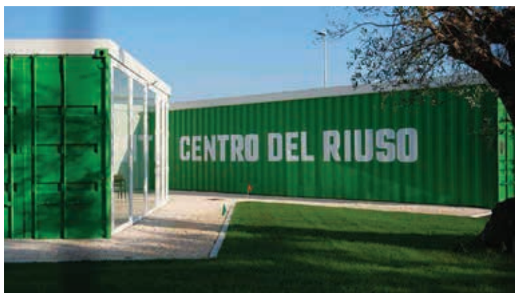
Fig. 6 | Centro del riuso di Montecassiano - Vista esterna
