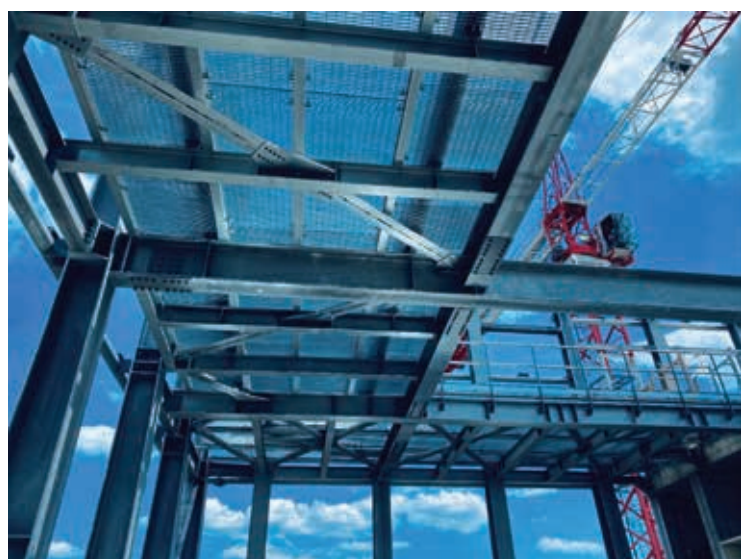
Fig. 16 | Montaggio della struttura, fasi 1 e 2.
