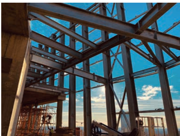
Fig. 17 | Fasi di montaggio della struttura.
