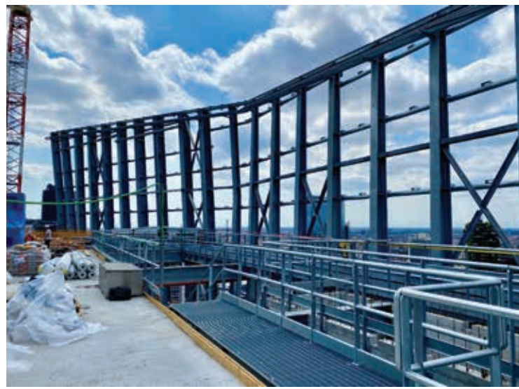
Fig. 19 | Fasi di montaggio della struttura.
