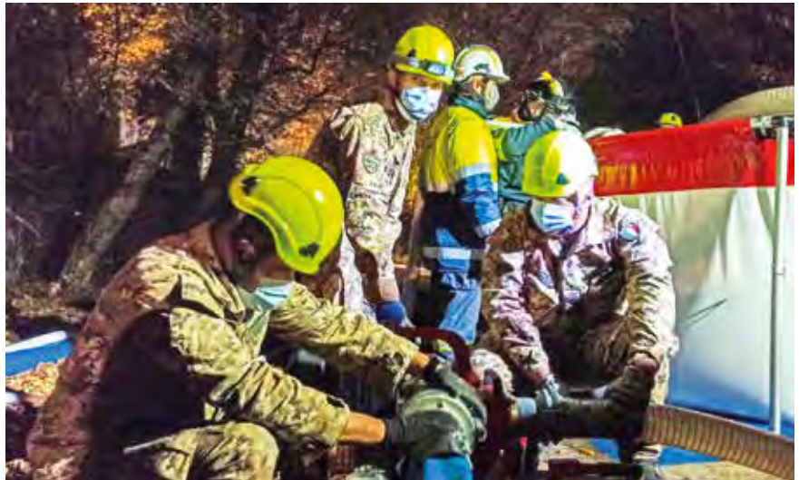
■ Pompaggio acqua ad alta capacità
