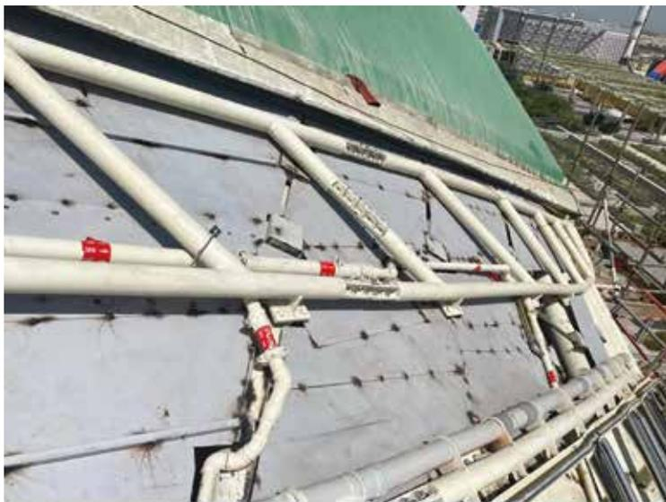
Fig. 19 | Trave reticolare irrigidente ed impianti nascosti dentro i gusci
