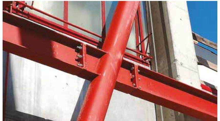
Fig. 17 | Dettaglio nodo pilastro inclinato e trave di bordo prima soletta
