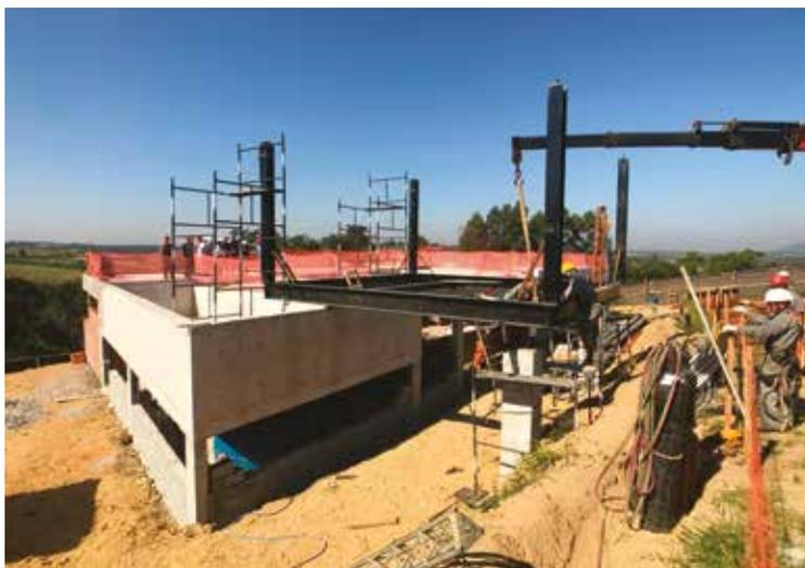
Fig. 29 | Fase di costruzione e assemblaggio della carpenteria metallica.
