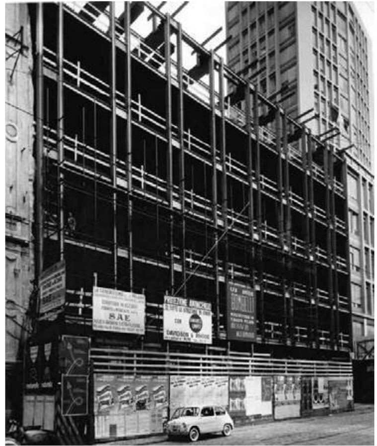
Fig. 10 - Secondo lotto in costruzione e sezione del sistema resistente dell'edificio per uffici su Via Turati (Archivio professionale Eugenio e Ermenegildo Soncini, "La Serenissima" (AS.12), © Comune di Milano - CASVA)
