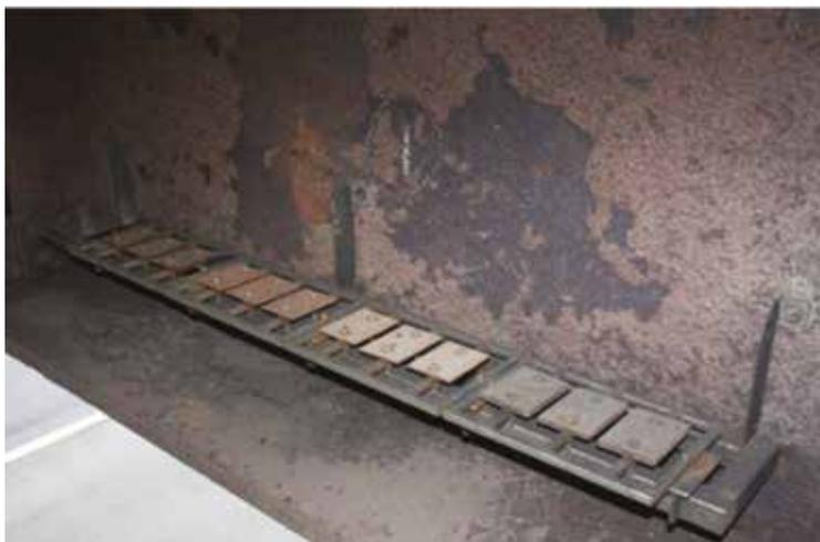
Fig. 3 | Provette per la determinazione della classe di corrosività atmosferica posizionate nella piattabanda inferiore di una trave di ponte (Moore Drive Bridge; foto da rapporto della Federal Highway Administration (FHWA), Publication Number: FHWA-HRT-11-062, novembre 2011).
