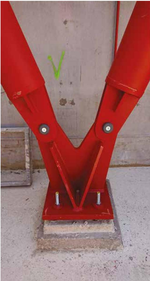
Fig. 15 | Dettaglio di base pilastri inclinati a V
