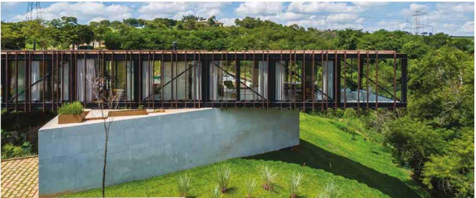
Fig. 8 | Vista del fronte sud e dell'appoggio della trave in acciaio sul basamento in calcestruzzo.
