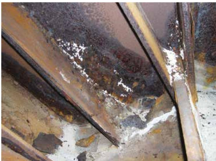
Fig. 5 | Condizioni di corrosione all'interno di una struttura scatolare in acciaio Cor-Ten.
