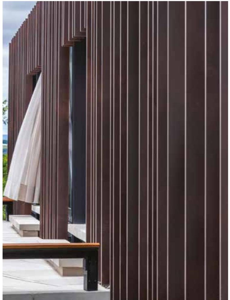
Fig. 18 | Vista degli anelli metallici esterni con funzione schermante.\
