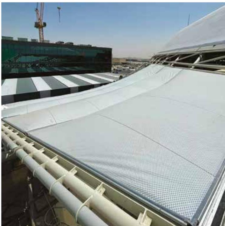
Fig. 21 | Cuscini in ETFE in fase di installazione
