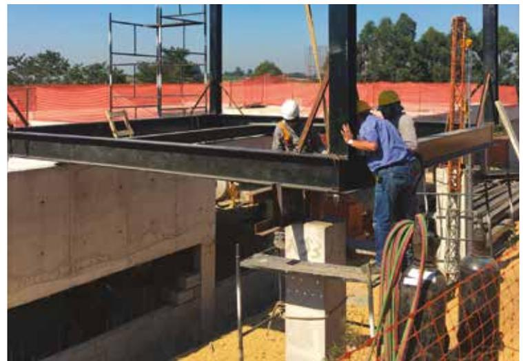
Fig. 30 | Fase di costruzione e assemblaggio della carpenteria metallica.
