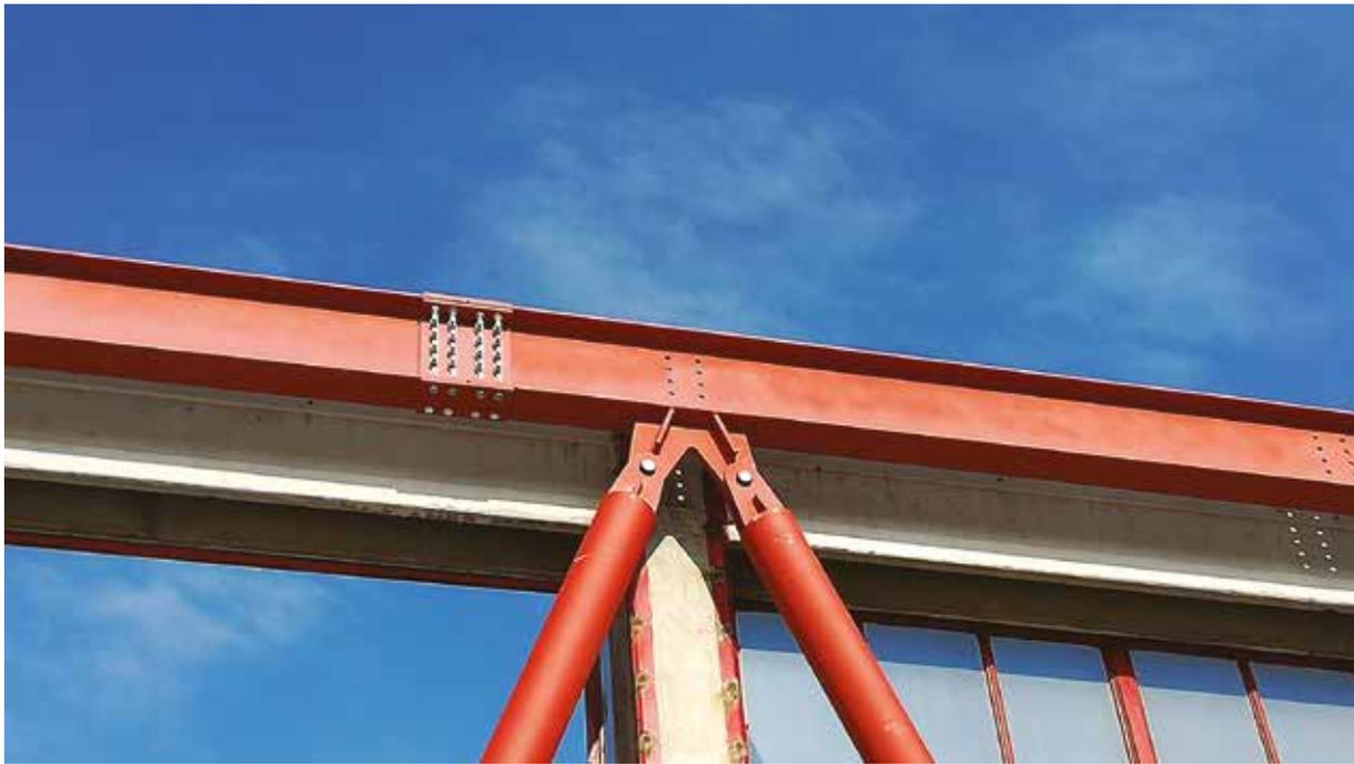
Fig. 19 | Dettaglio di sommità pilastri a V
