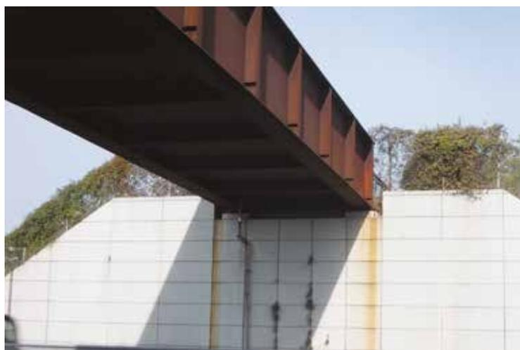
Fig. 9 | Macchiatura delle strutture sottostanti ad una trave in acciaio Cor-Ten.
