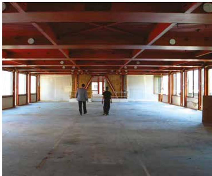
Fig. 20 | Elementi strutturali messi a nudo dopo la rimozione delle finiture (© Park Associati)
