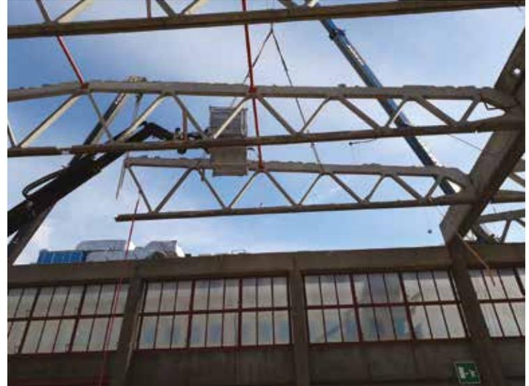
Fig. 2 | Demolizione capriate di copertura
