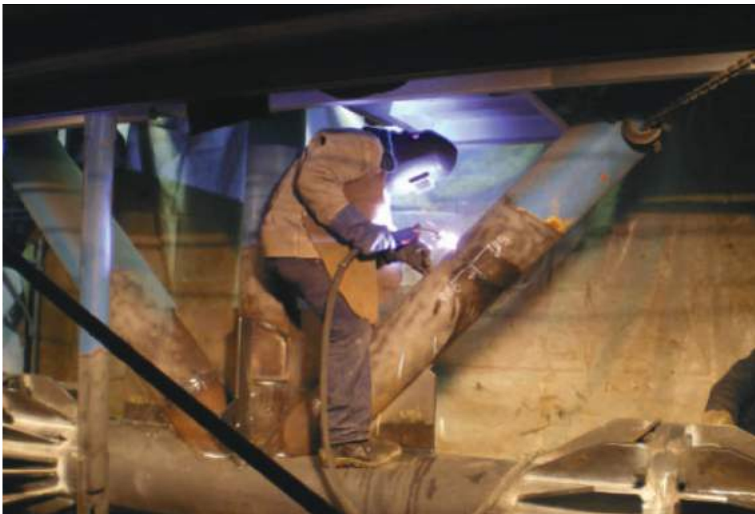
Fig. 4 | Fasi di riparazione di una infrastruttura metallica.
