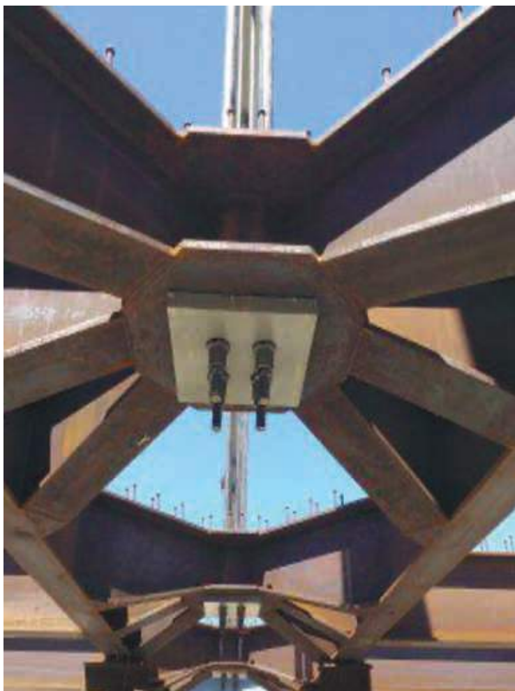
Fig. 22 | Dettaglio del sistema di collegamento tra i pendini e il graticcio di travi formanti l'impalcato
