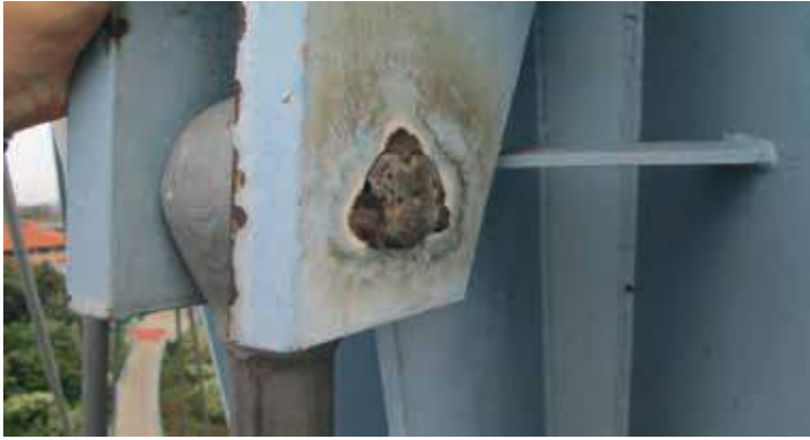
Fig. 14 | Assenza di coperchi di chiusura.
