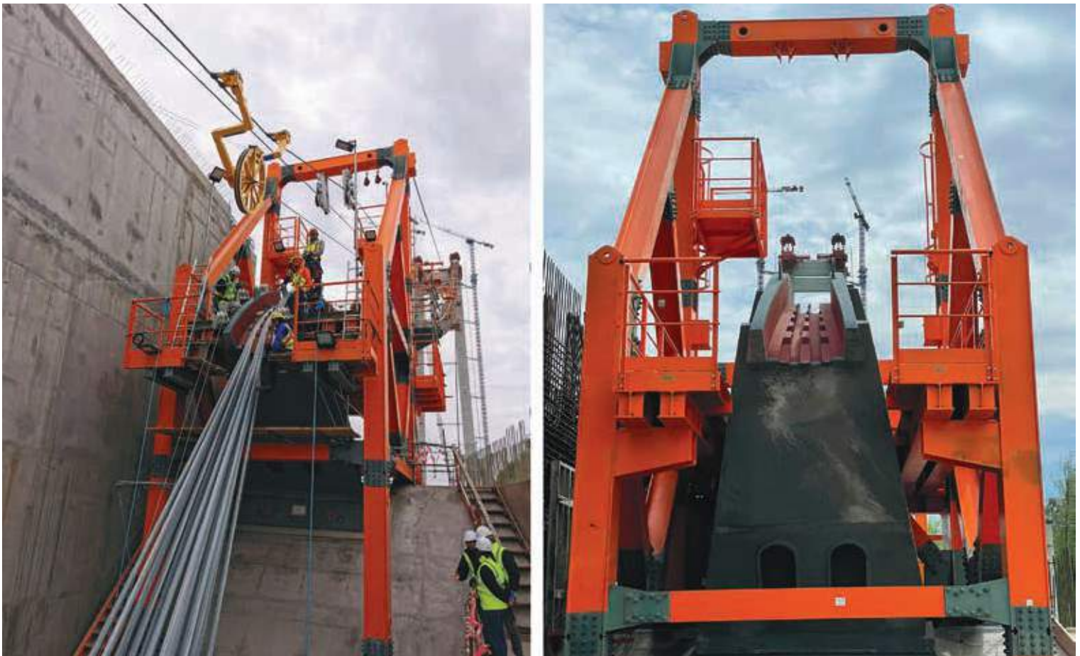
Fig. 22 | Pettine di deviazione alla messa in opera e durante la realizzazione del cavo principale
