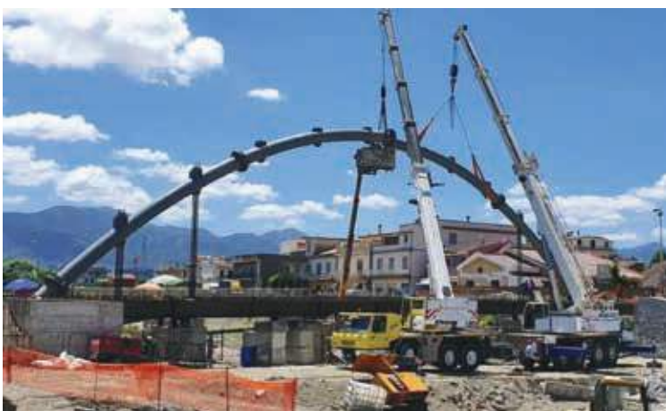
Fig. 23 | Operazione di assemblaggio dell'arco metallico: giunto di continuità in chiave
