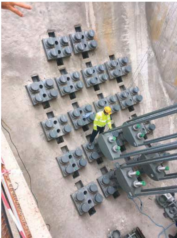
Fig. 23 | Sistema di ancoraggio
