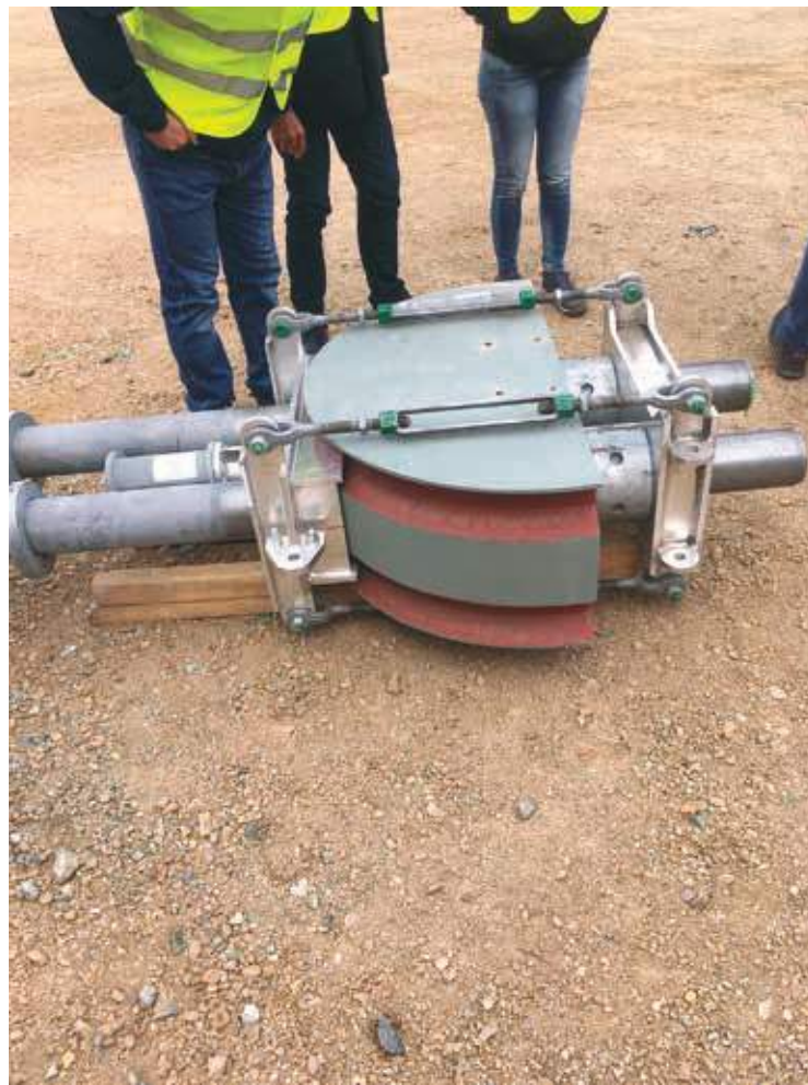
Fig. 24 | Sella di ritorno per l'ancoraggio al blocco
