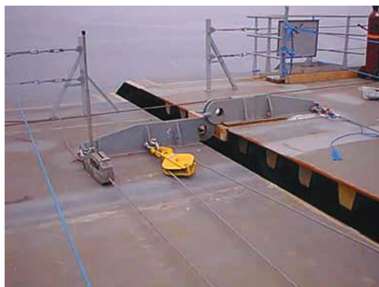
Fig. 78 | Connessione temporanea di montaggio del ponte sospeso dello Storebaelt
