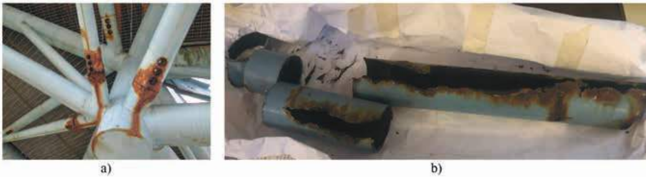
Fig. 11 | Fenomeni di corrosione nelle situazioni critiche: a) nodi di giunzione; b) tubolari di collegamento.
