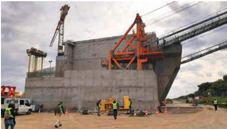
Fig. 12 | Struttura di transizione
