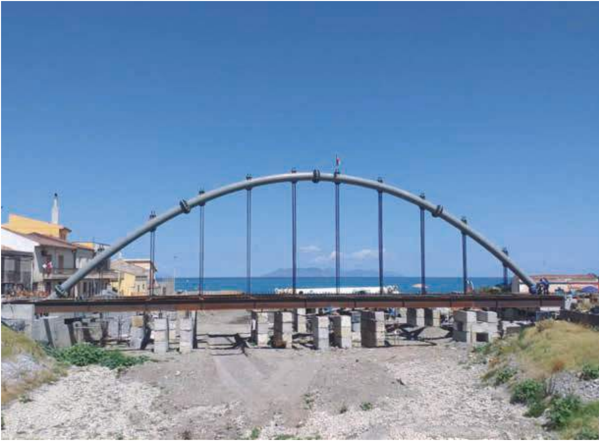
Fig. 37 | Vista longitudinale dell'opera durante le fasi di completamento
