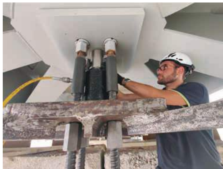
Fig. 24 | Operazione di tesatura dei pendini
