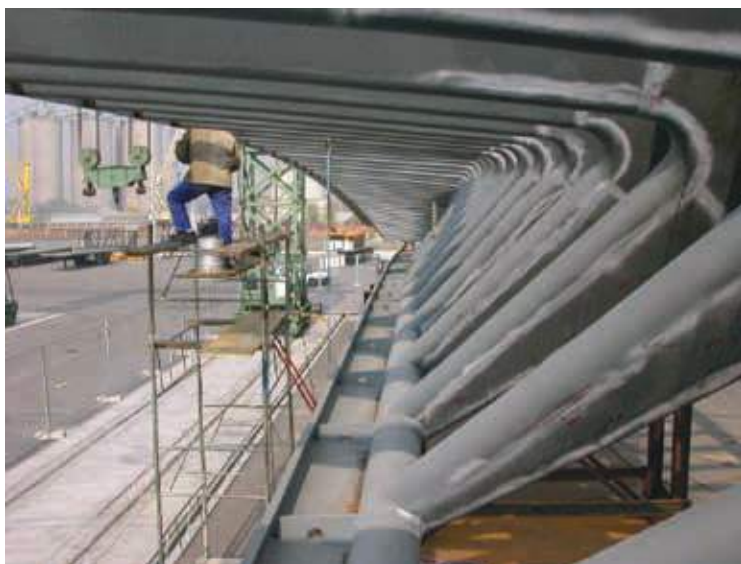
Fig. 1 | Ponte della Costituzione, Venezia, durante la prefabbricazione.
