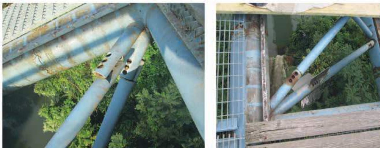
Fig. 10 | Giunzioni della passerella trovate prive di bullonatura (situazioni critiche ed inderogabili): a) diagonali inclinate; b) diagonale di piano.
