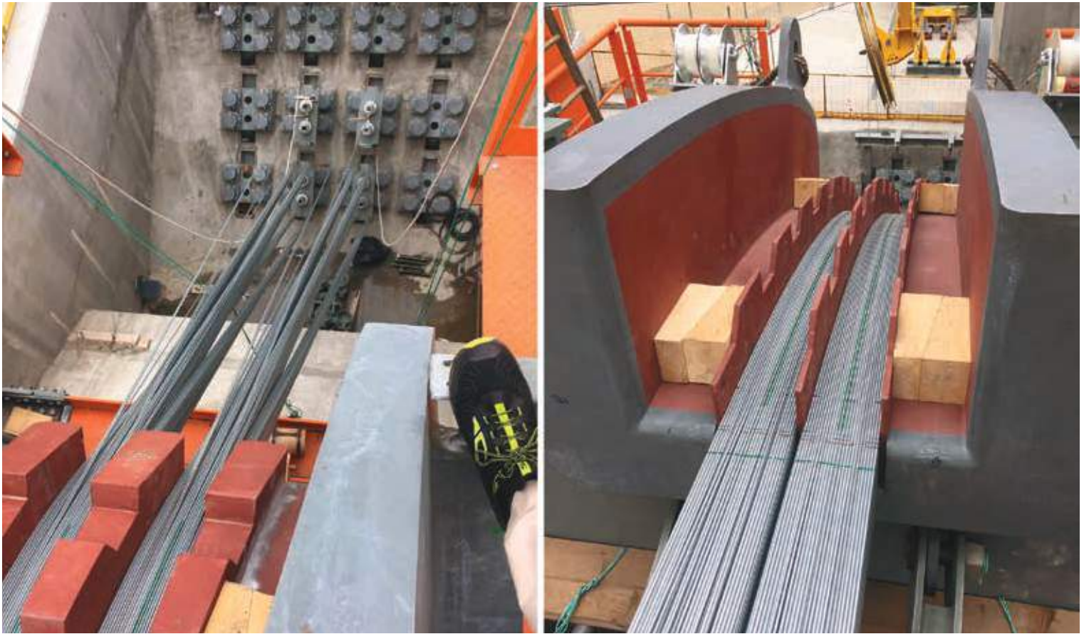
Fig. 21 | Dettaglio delle gole del pettine di deviazione
