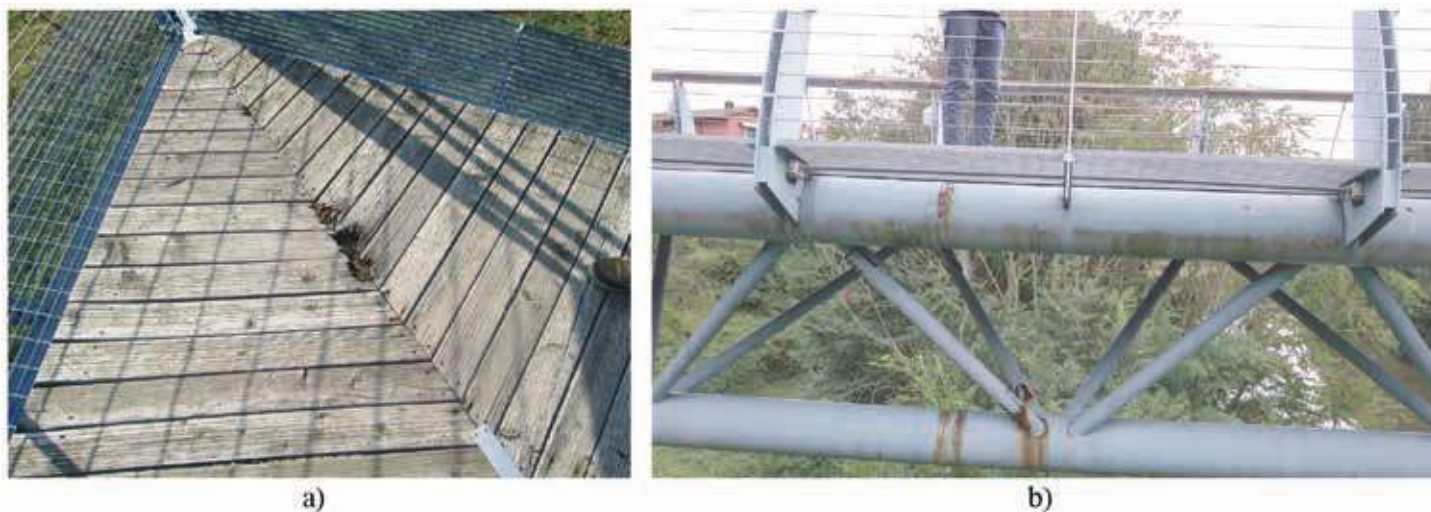
Fig. 13 | Degrado e/o danneggiamento nelle situazioni non critiche: a) elementi in legno che costituiscono il piano di calpestio; b) sistemi di fissaggio dei corrimani della passerella.
