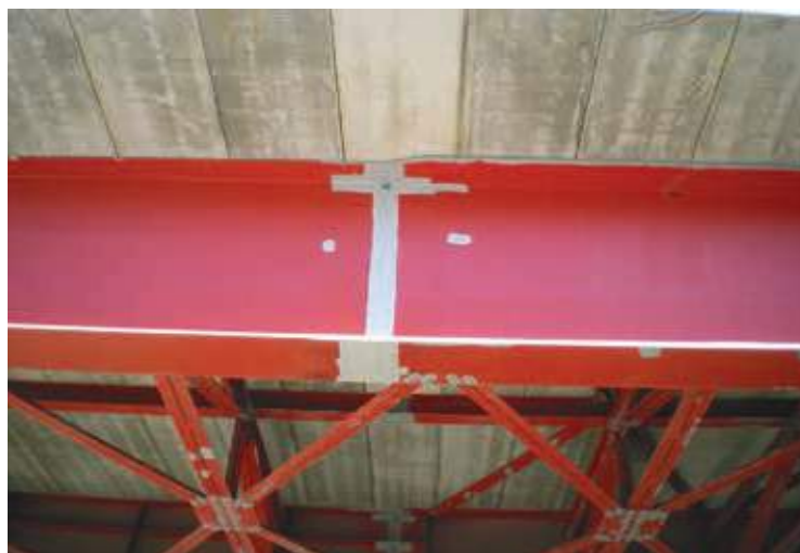
Fig. 2 | Giunto di collegamento tra anima e piattabande di ogni concio.
