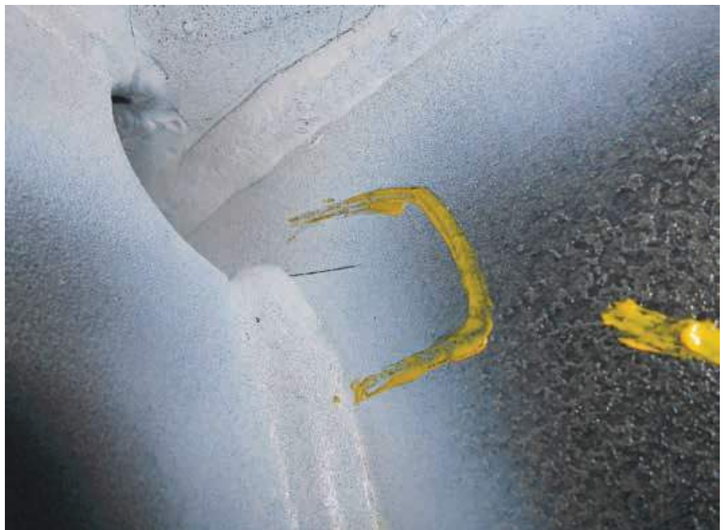
Fig. 7 | Cricca di fatica all'incrocio tra elementi di irrigidimento, rilevata con metodo di controllo magnetoscopico, tecnica con elettromagnete e vernice bianca di contrasto.
