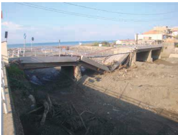
Fig. 2 | Il ponte Calderà dopo il cedimento della pila 2, 22 novembre 2011
