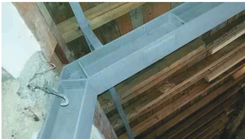
Fig. 8 | Giunzione testa a testa con doppiature di rinforzo: soluzione sconsigliata perché il giunto testa a testa non è più ispezionabile dopo la sovrapposizione delle piastre.
