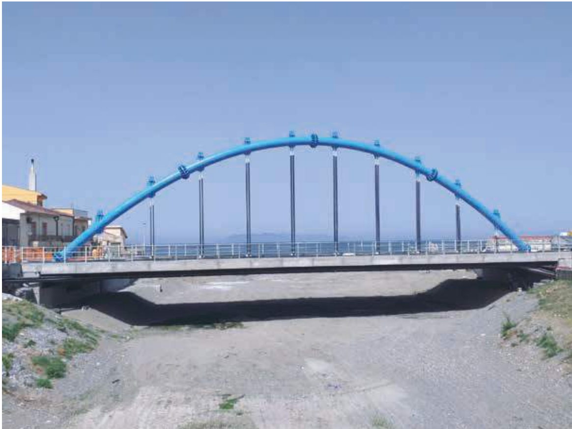
Fig. 38 | Vista longitudinale dell'opera terminata
