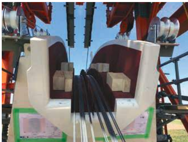
Fig. 17 | Sella per il cavo principale in sommità delle torri, vista generale e dettagli delle gole
