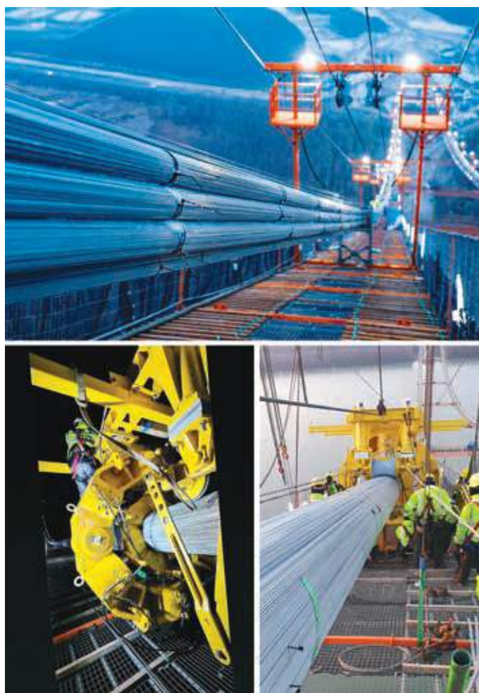
Fig. 15 | Un cavo principale durante la realizzazione e le successive operazioni di compattazione
