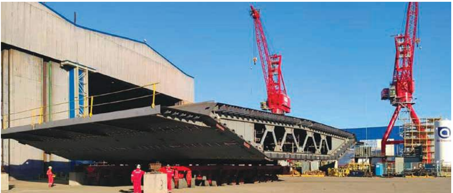
Fig. 28 | Concio impalcato corrente
