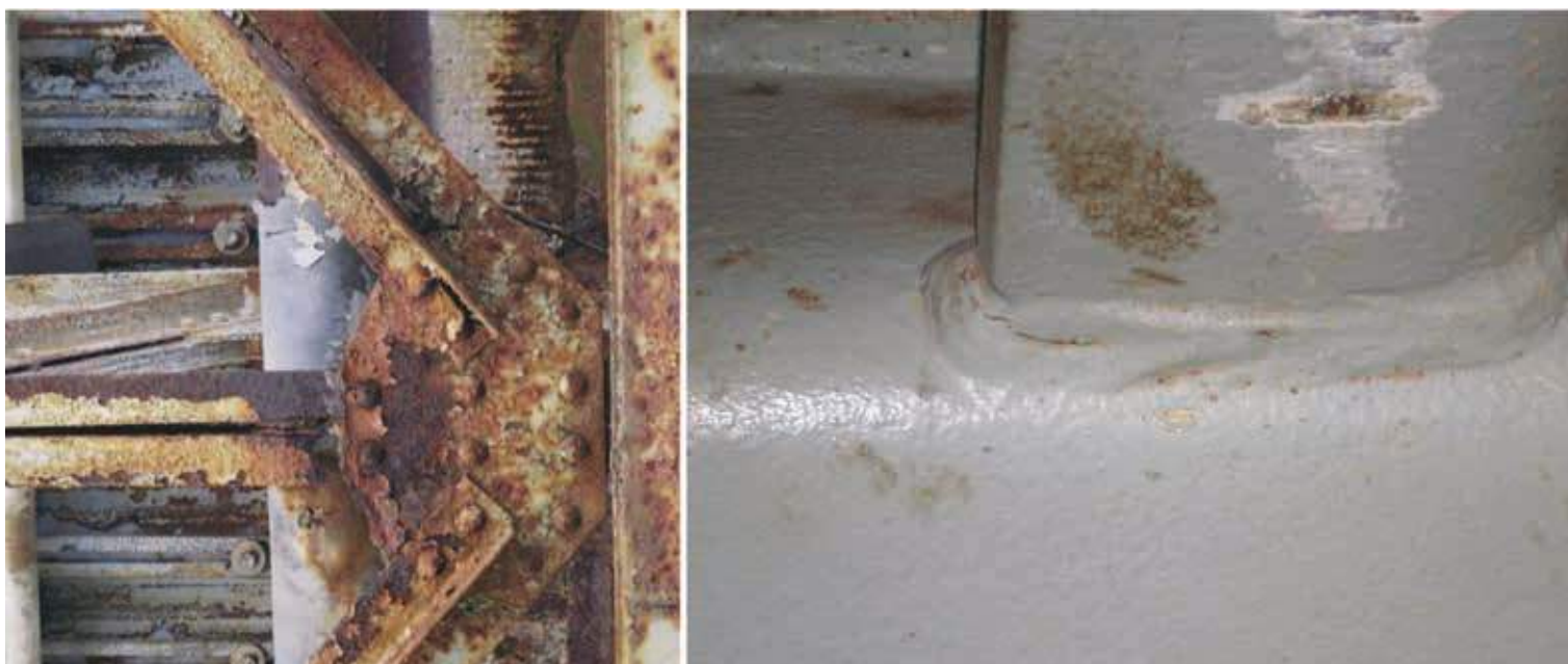
Fig. 2 | A sinistra, fenomeni di corrosione su giunzioni chiodate. A destra, cricca di fatica.
