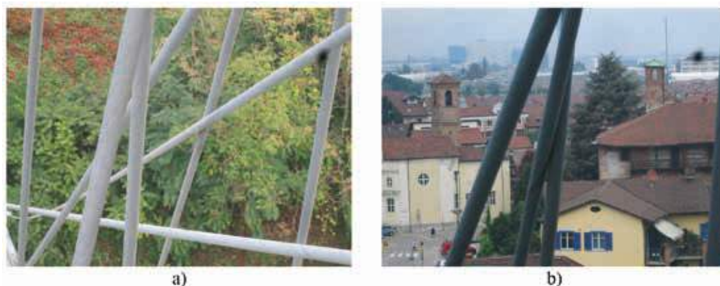
Figura 12 | Situazioni critiche nel sistema di stralli: a) interferenza di alcuni stralli con il parapetto della rampa; b) interferenza tra gli stralli stessi.
