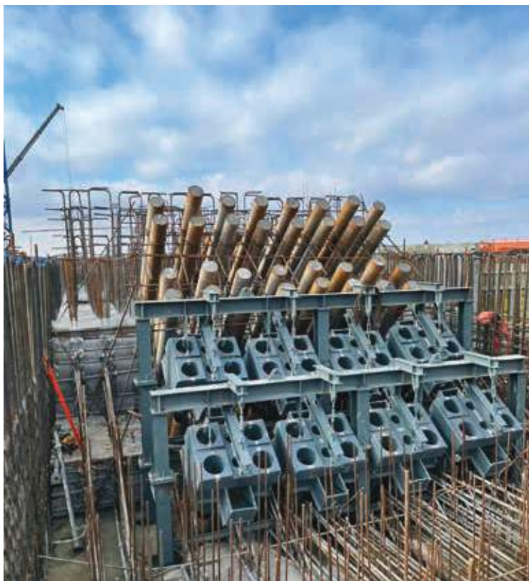
Fig. 25 | Carpenteria metallica di collegamento
