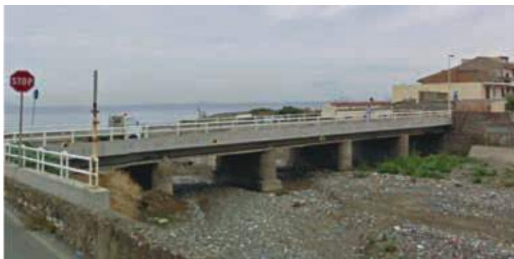
Fig. 1 | La situazione del ponte Calderà fino al 22 novembre 2011
