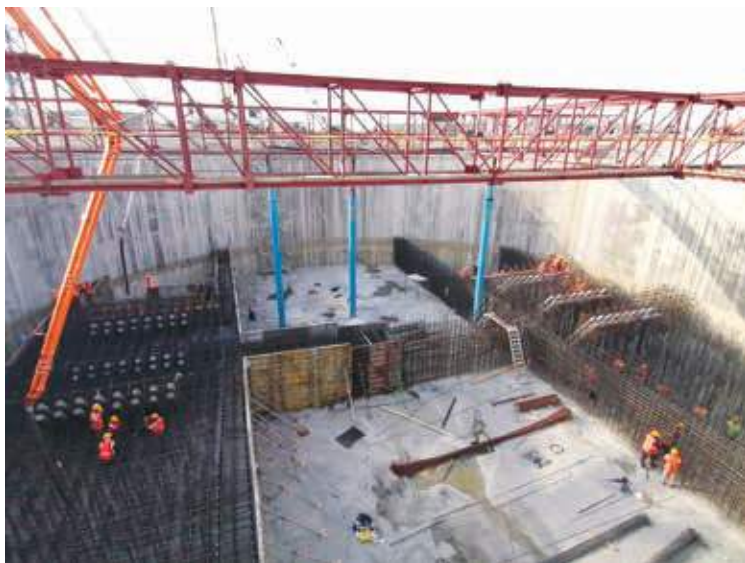
Fig. 11 | Spaccato assonometrico delle camere di ancoraggio, vista della camera superiore durante la costruzione
