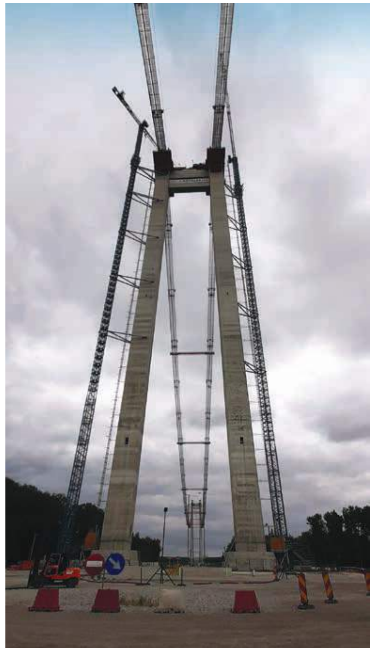
Fig. 13 | Torre lato Braila
