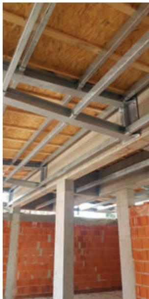
Fig. 11 | Particolare telaio centrale in c.c.a.
