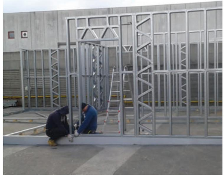
Fig. 22 | Fase di montaggio per test posa.
