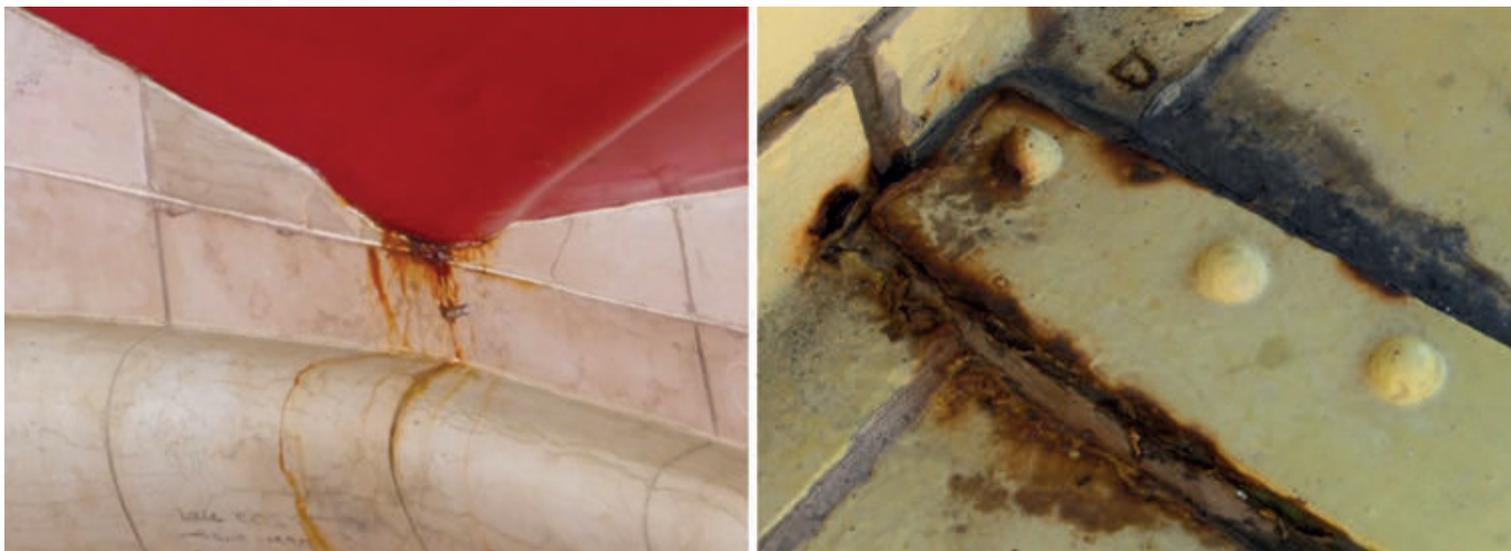
Fig. 4 | Esempi di primi segni di degrado e degrado importante di strutture in acciaio verniciato.
