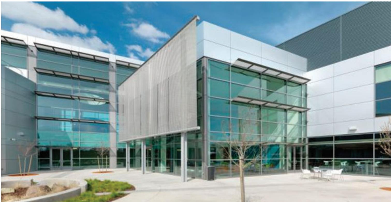
Fig. 14 | Esempio di applicazione con coiled wire fabric system
