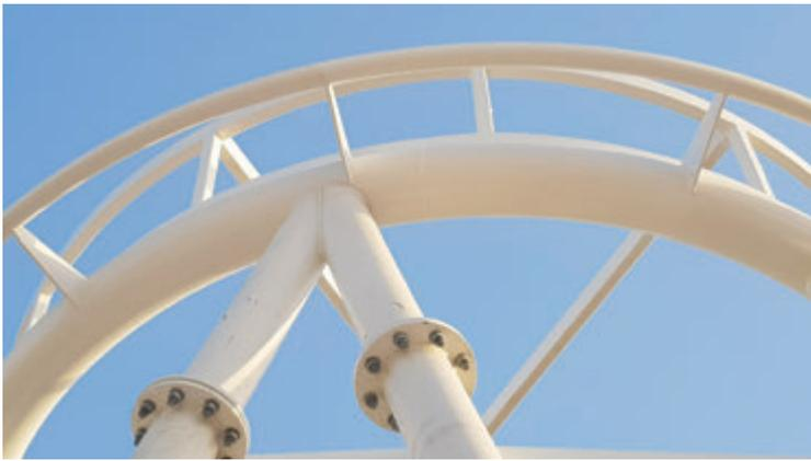
Fig.27 | Dettaglio sistema di connessione © Amann-Canovas-Maruri
