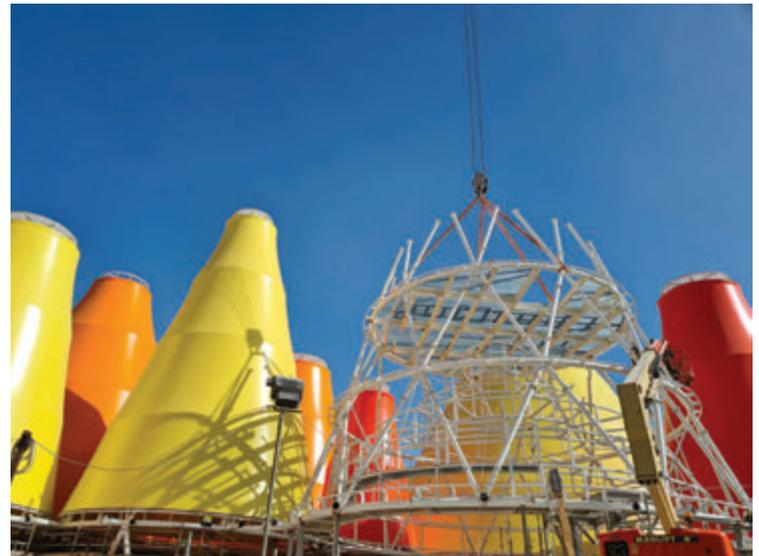
Fig.22 | Assemblaggio solette cono © Amann-Canovas-Maruri
