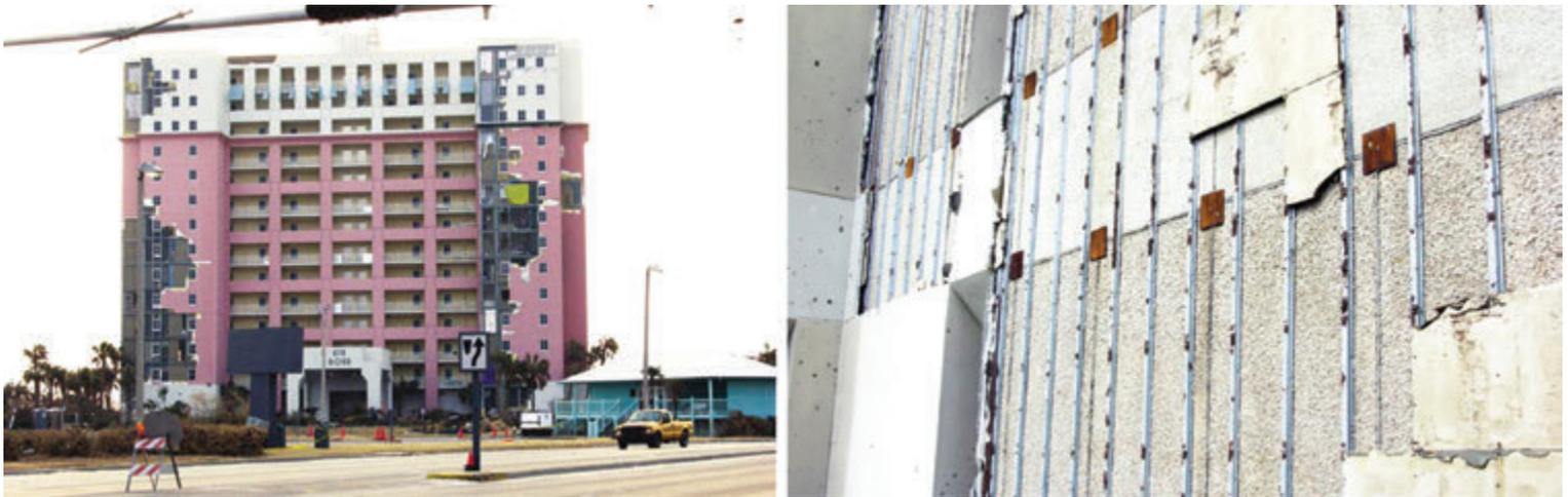
Fig. 7 | Distacco del paramento in cartongesso dalla sottostruttura di facciata di due edifici in Pensacola (Florida)
