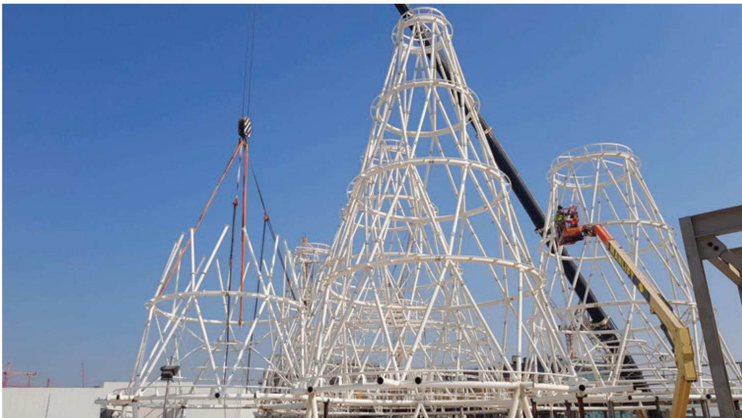
Fig.24 | Assemblaggio struttura metallica © Amann-Canovas-Maruri
