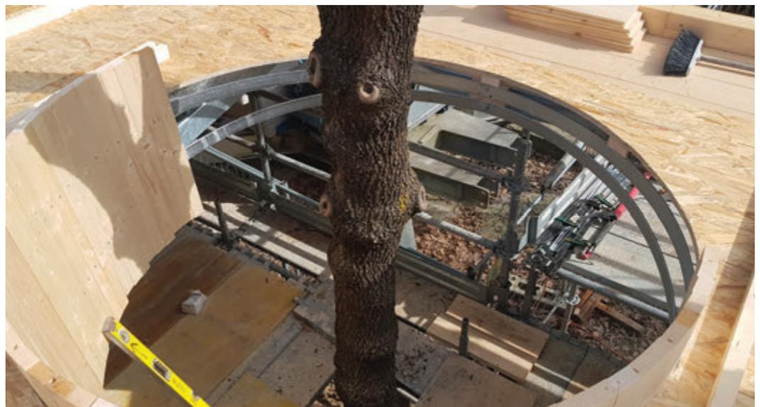
Fig. 12 | Particolare del foro per l'albero nella copertura
