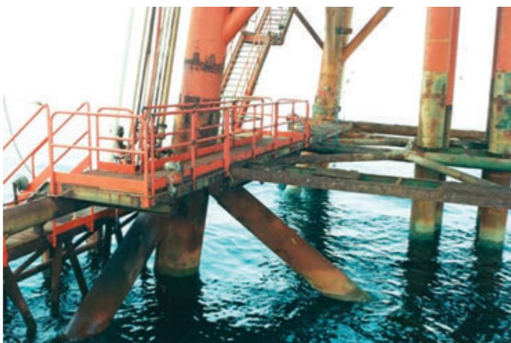
Fig. 5 | Zona di marea e di splash di una piattaforma offshore con pesanti segni di degrado del sistema protettivo.
