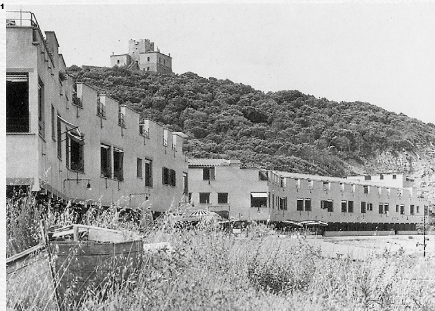
1 Ignazio Gardella, Cala del Pozzo residential complex, Punta Ala harbor (Castiglione della Pescaia), 1962-66. Period photo / Foto d'epoca.
