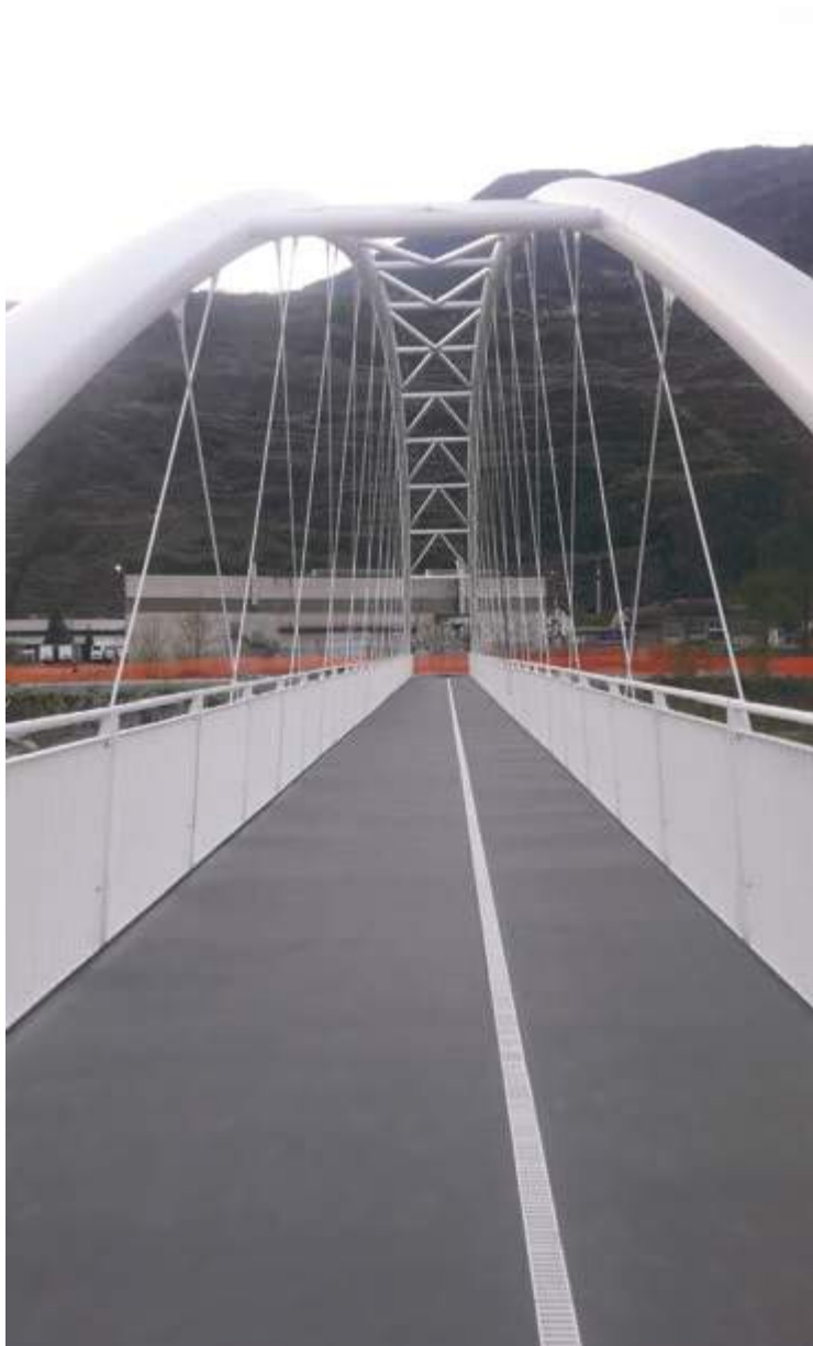
Fig. 35 | Vista del ponte finito.
