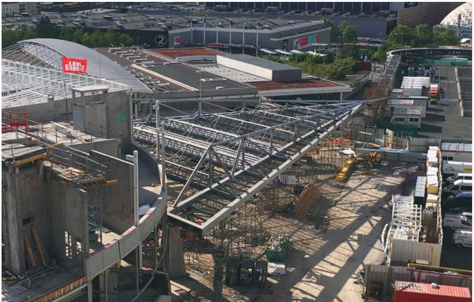
Fig. 21 | Montaggio della struttura secondaria-terziaria-quaternaria su pile provvisorie
