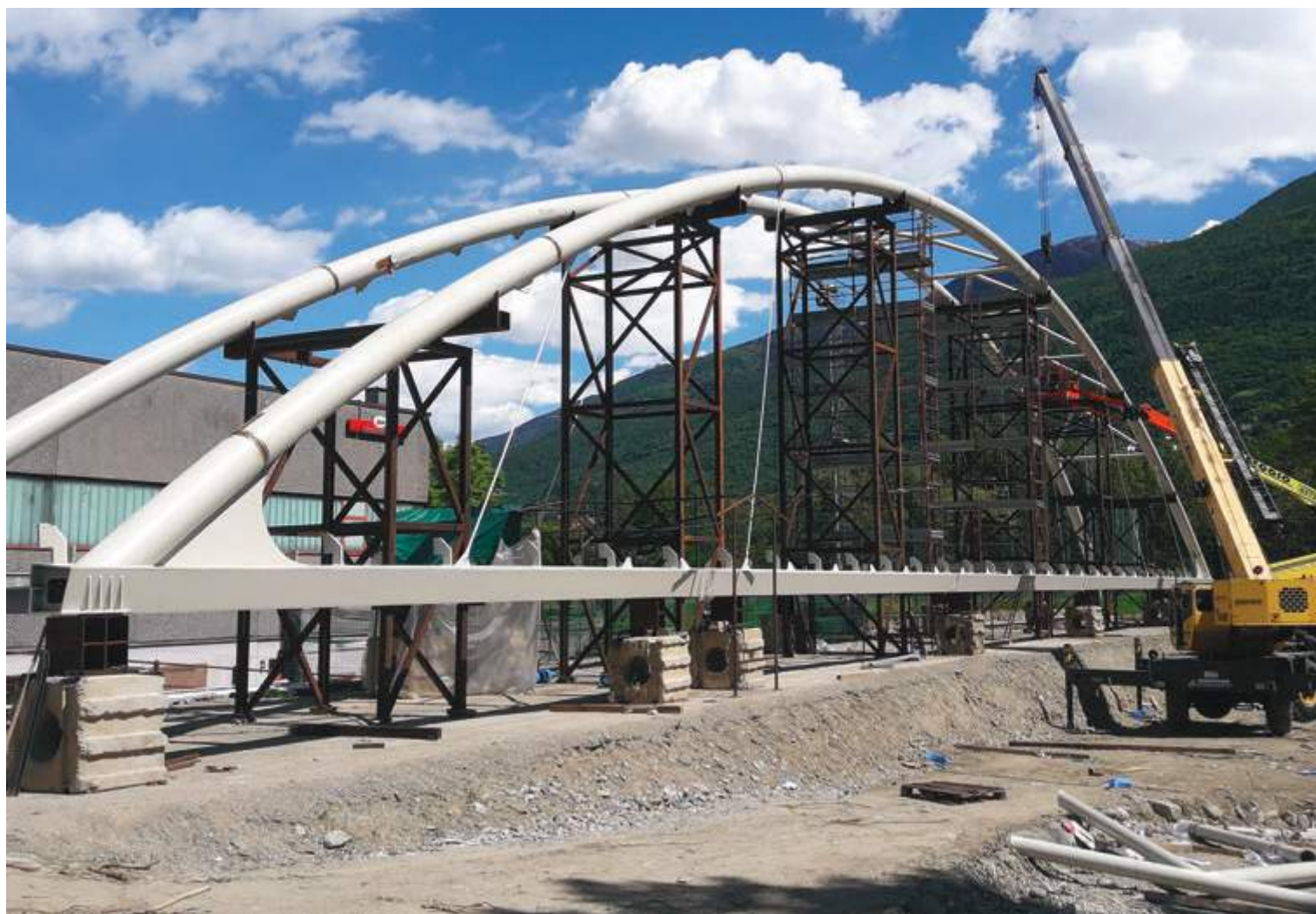
Fig. 29 | Assemblaggio della struttura metallica.
