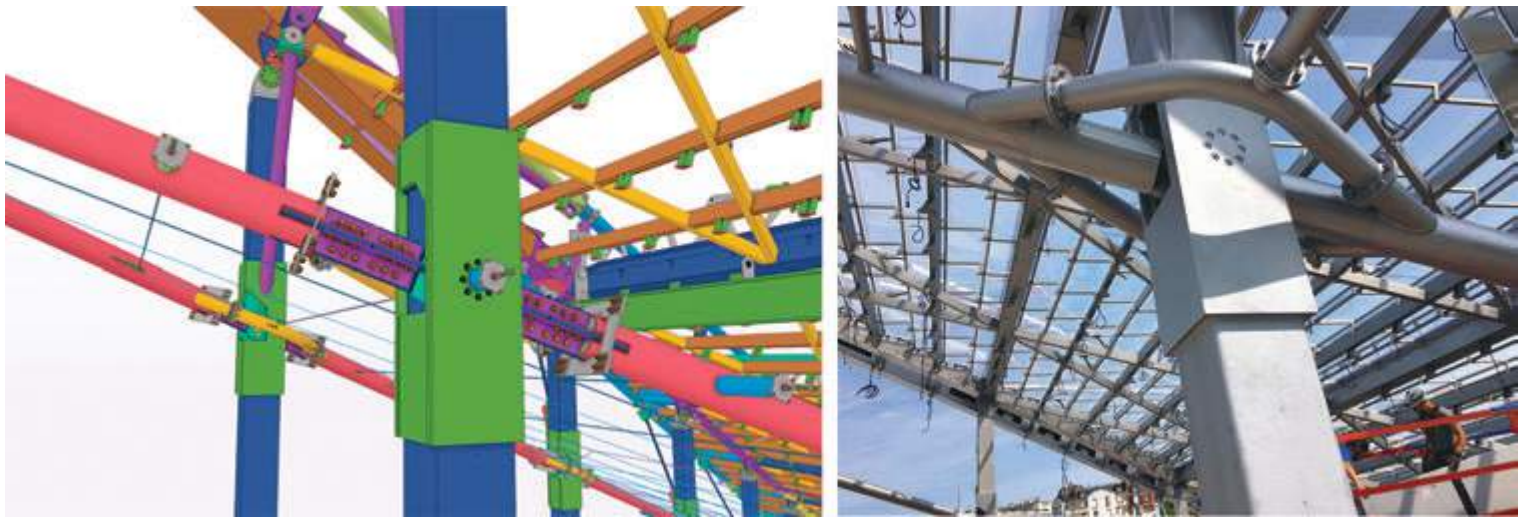
Fig. 19 | Dettagli nodi sferici in corrispondenza del collegamento Totem - Butons
