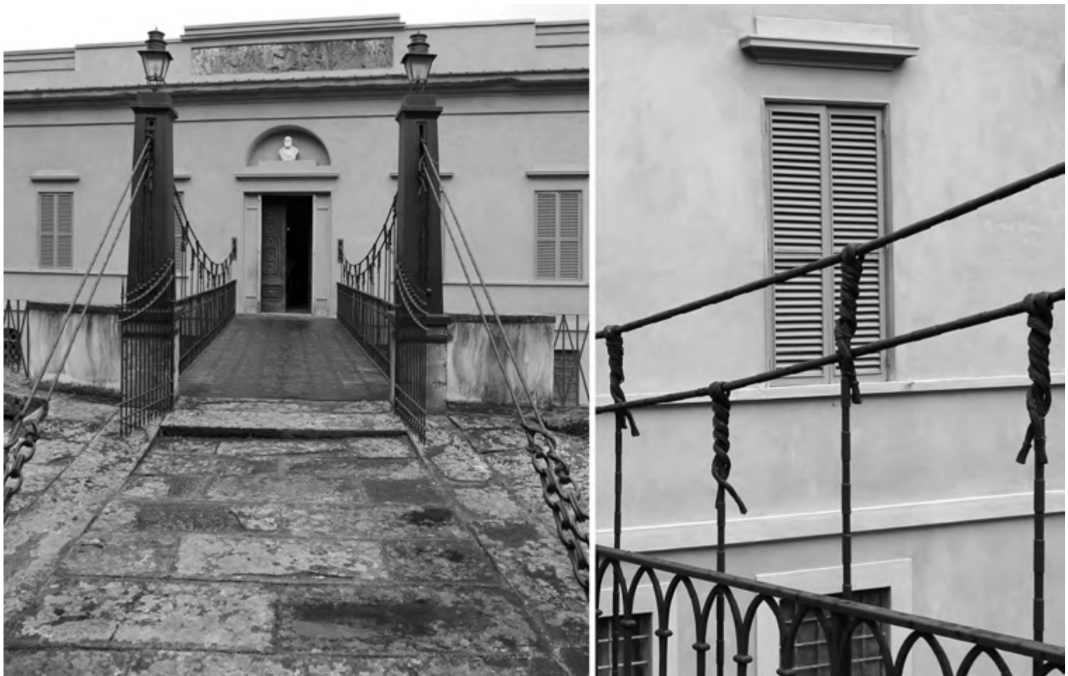
Fig. 3 | Passerella di accesso al piano nobile della Villa Paolina a Sesto Fiorentino del 1825: vista d'insieme e dettaglio del collegamento tra gomene e tiranti in fili di ferro (Saliko, 2019).
