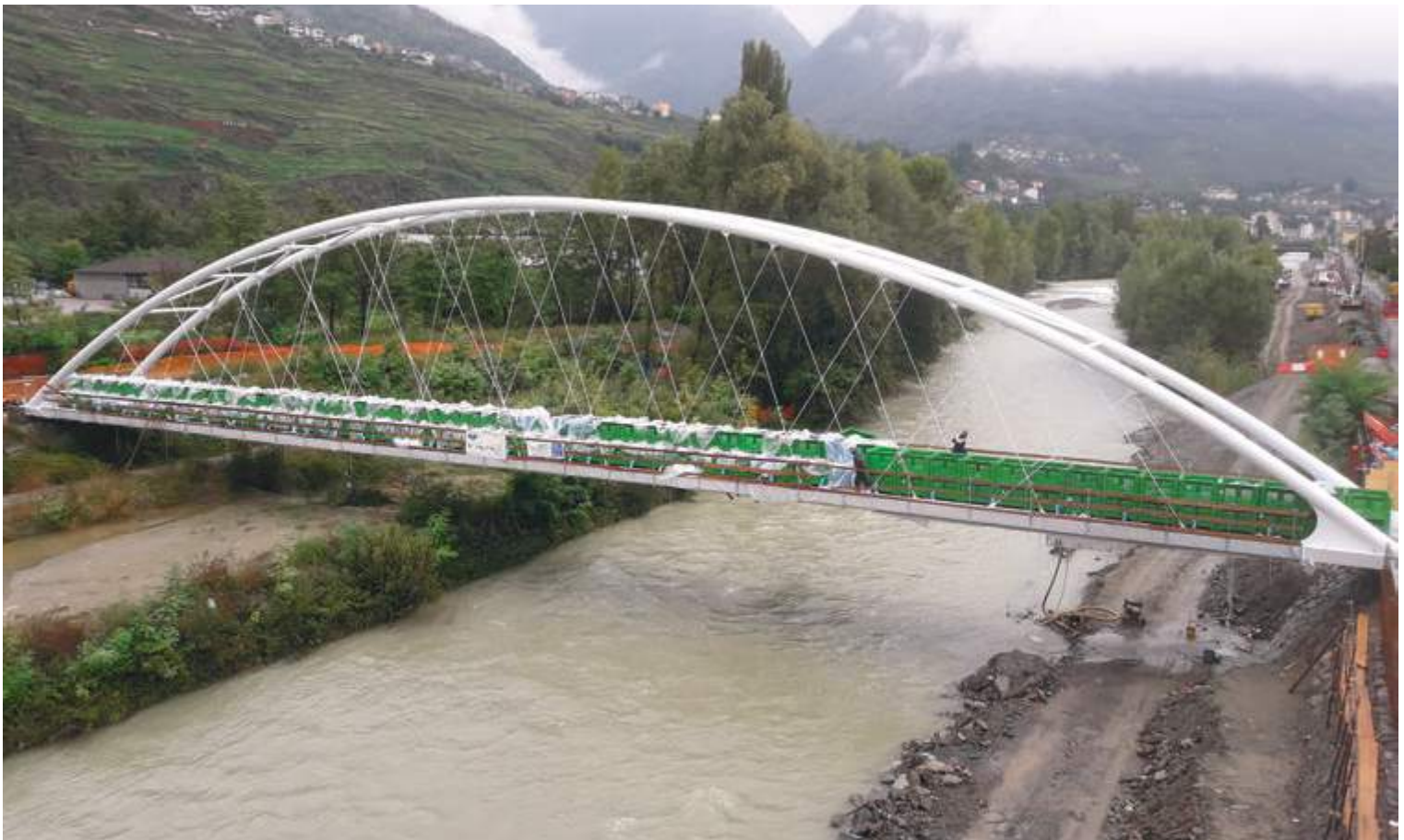
Fig. 34 | Prova di carico con cestoni riempiti d'acqua: vista longitudinale (sx) e trasversale (dx).
