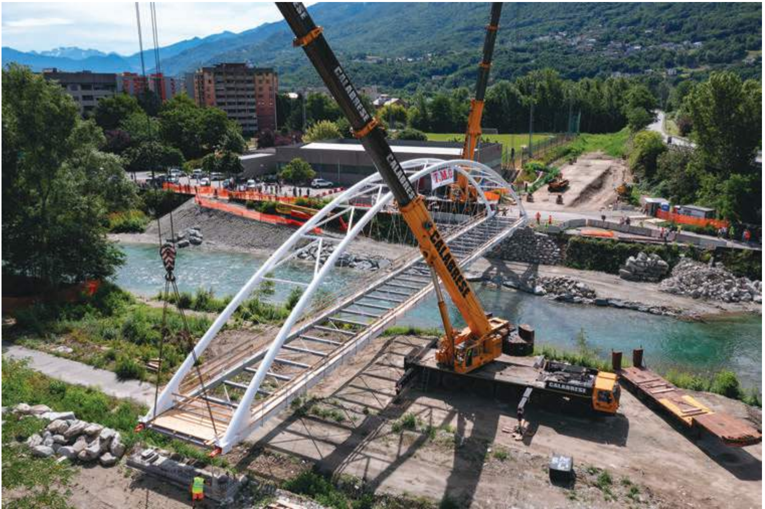
Fig. 32 | Varo del ponte con due autogrù; vista lato alveo.
