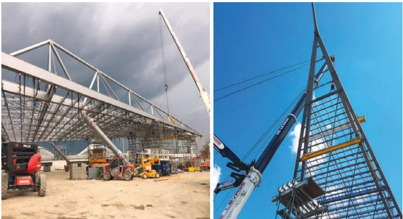
Fig. 22 | Sollevamento Auvent con autogrù
