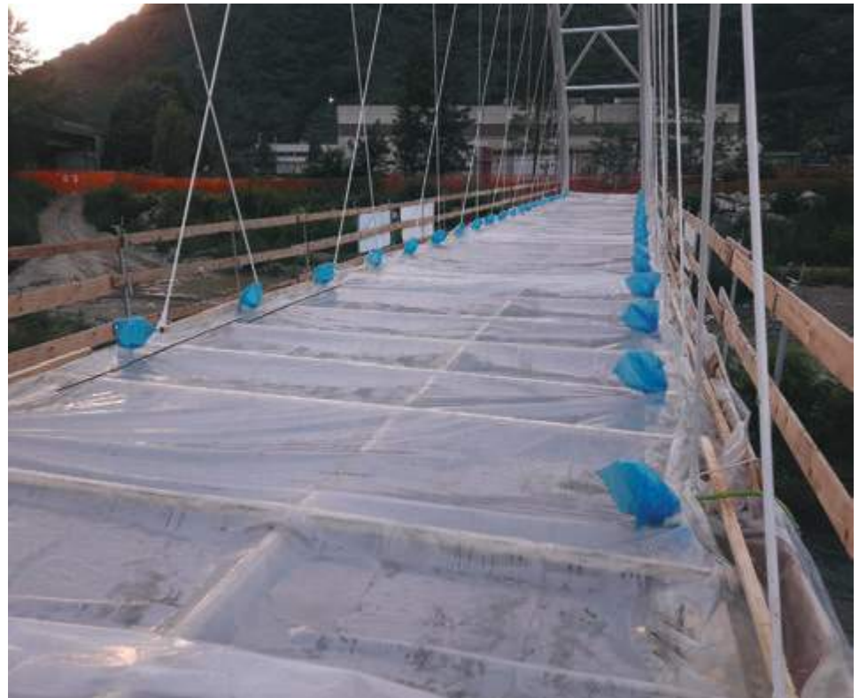
Fig. 33 | Protezione della superficie del calcestruzzo durante l'avanzamento del getto (sx) e a operazioni concluse (dx).
