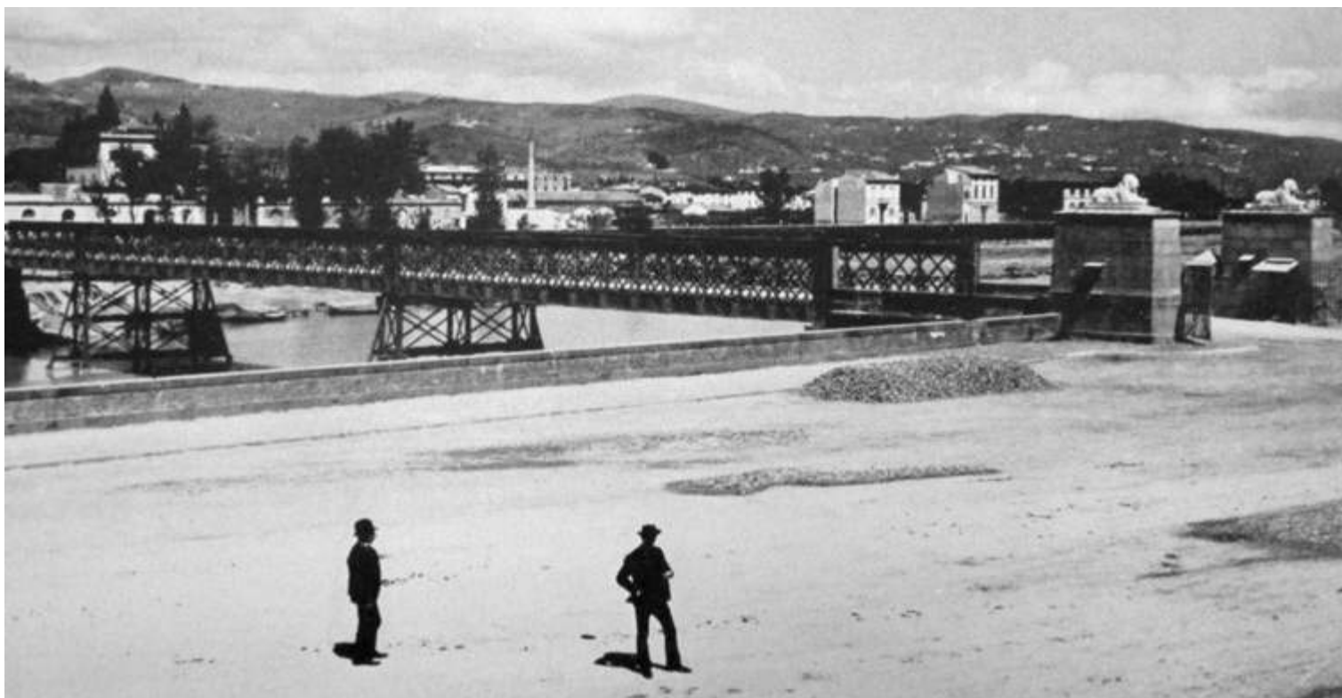
Fig. 17 | Ponte San Ferdinando: vista del ponte a travata continua realizzato nel 1890 (Detti, 1977).
