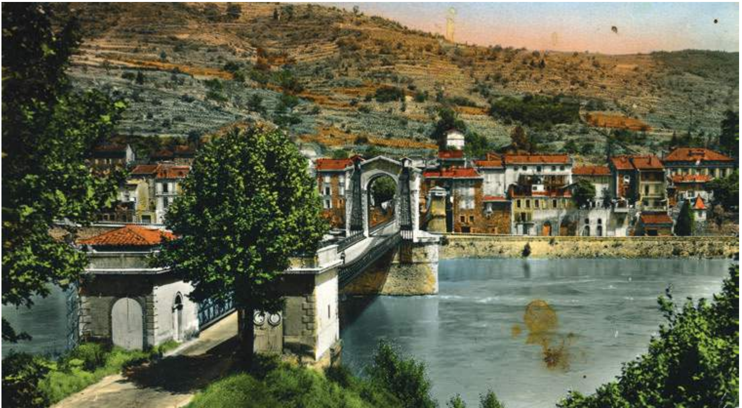
Fig. 6 | Ponte sul fiume Galaure a Saint-Vallier realizzato da Marc Seguin nel 1823 (Bibliothèque municipale de Lyon. Photographes en Rhône-Alpes, 1945).
