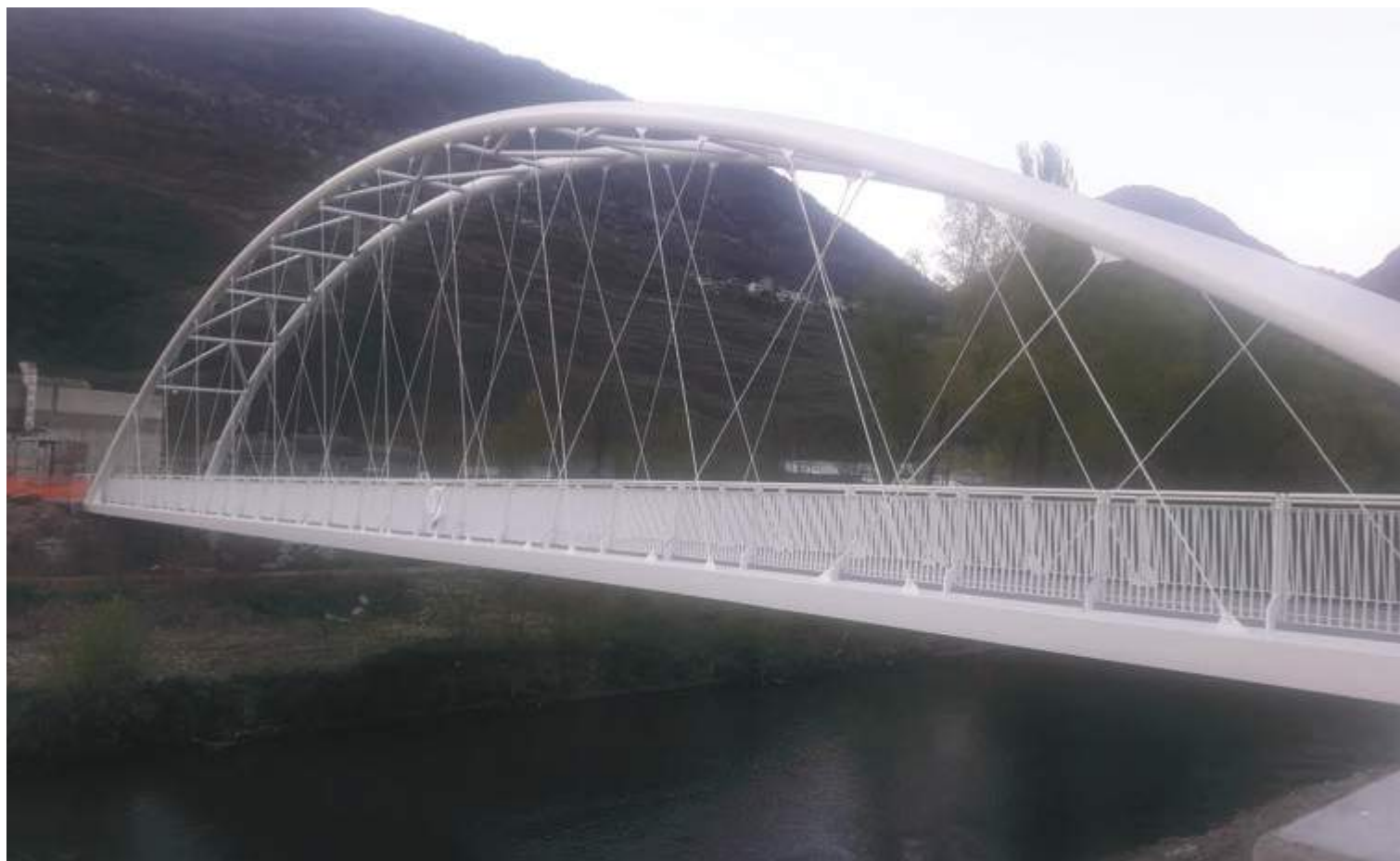
Fig. 1 | Ponte sul torrente Mallero.
