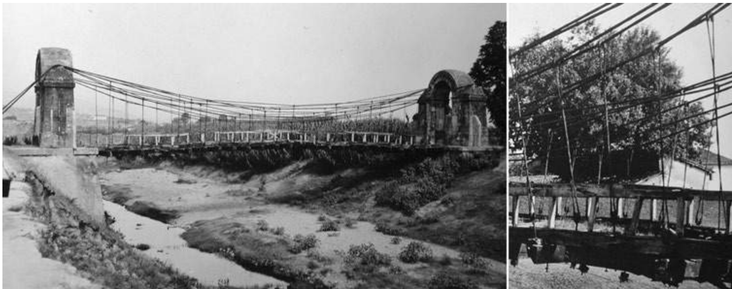
Fig. 4 | Ponte sul fiume Ombrone nei giardini della Villa Medicea a Poggio a Caiano del 1833: vista d'insieme e primo piano del sistema di sospensione dell'impalcato ligneo (Archivio Fotografico dell'Istituto Agronomico per l'Oltremare di Firenze, 1936).
