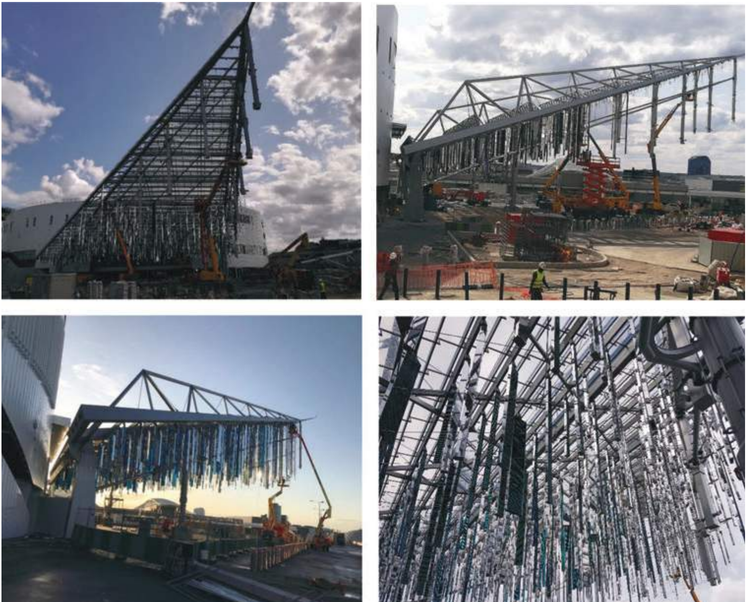
Fig. 24 | Montaggio Totem - Butons- Nappe
