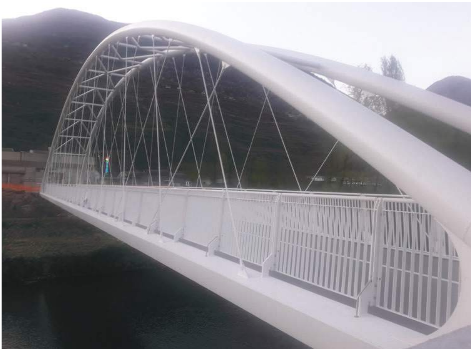
Fig. 37 | Vista esterna ponte finito
