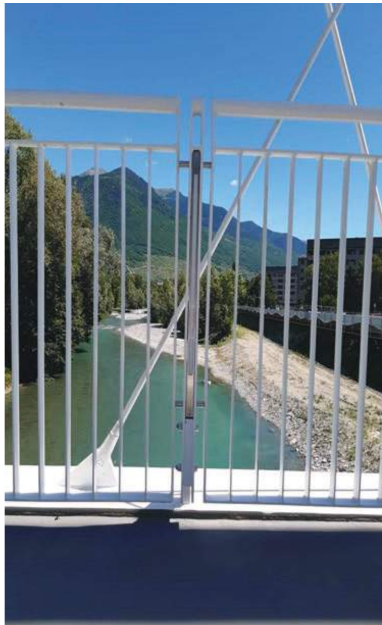
Fig. 36 | Dettaglio del parapetto con luce integrata nel montante
