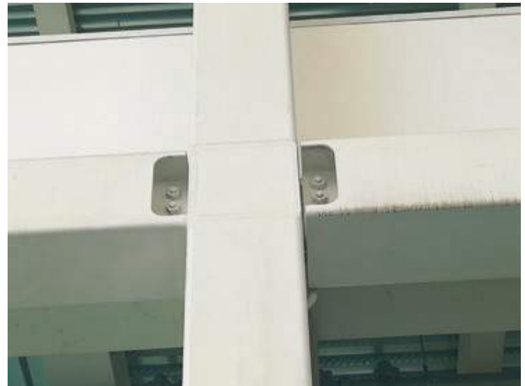
Fig. 19 | Foto del nodo con i tubi quadrati
