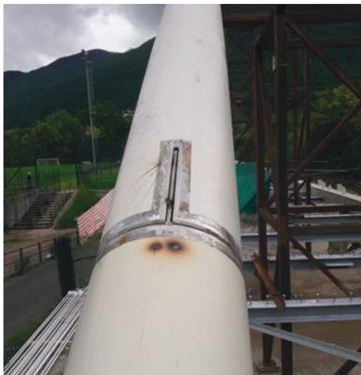
Fig. 10 | Dettaglio preparazione per la saldatura di giunzione dell'arco; si nota la fascia non zincata a cavallo della saldatura.
