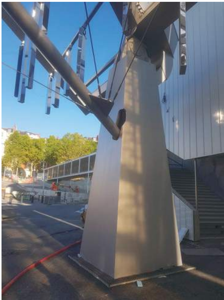
Fig. 11 –Pila in Acciaio
