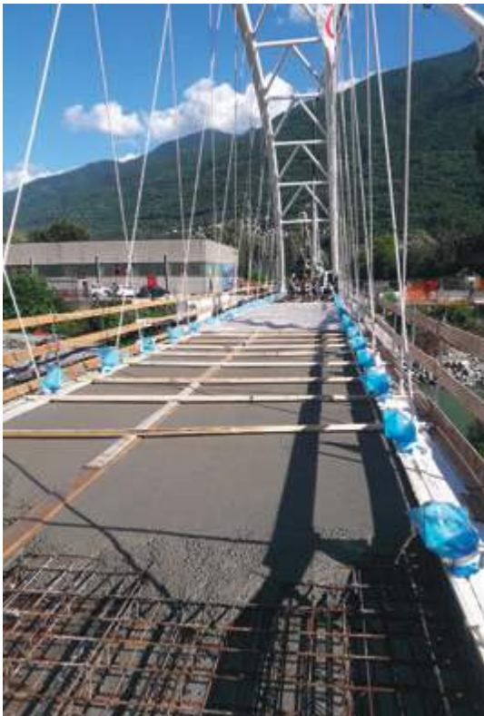
Fig. 33 | Protezione della superficie del calcestruzzo durante l'avanzamento del getto (sx) e a operazioni concluse (dx).
