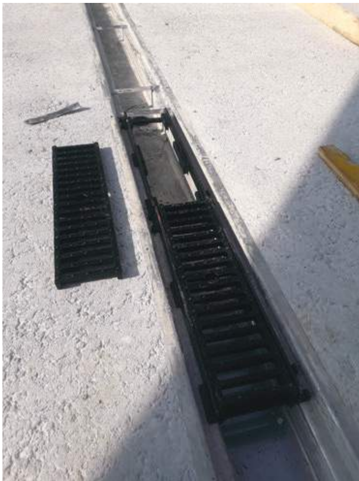
Fig. 9 | Dettaglio canaletta annegata nel getto con dente di appoggio per la griglia in ghisa con relativo telaio.
