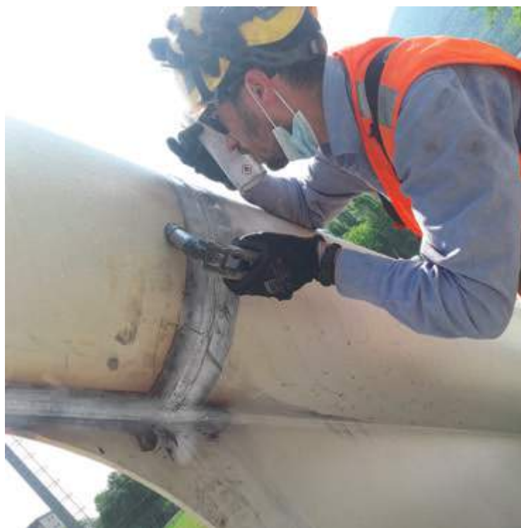
Fig. 11 | Controlli saldature in cantiere effettuati da IIS.
