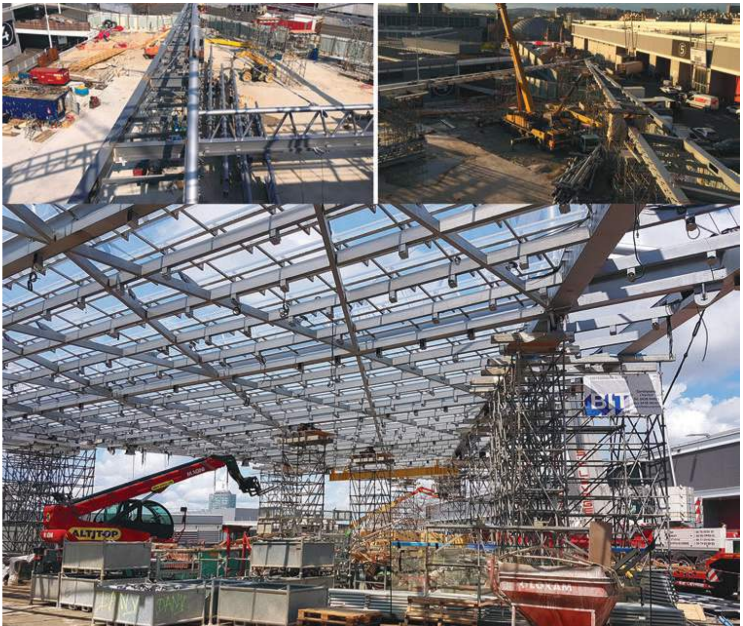
Fig. 20 | Montaggio della struttura primaria su pile provvisorie
