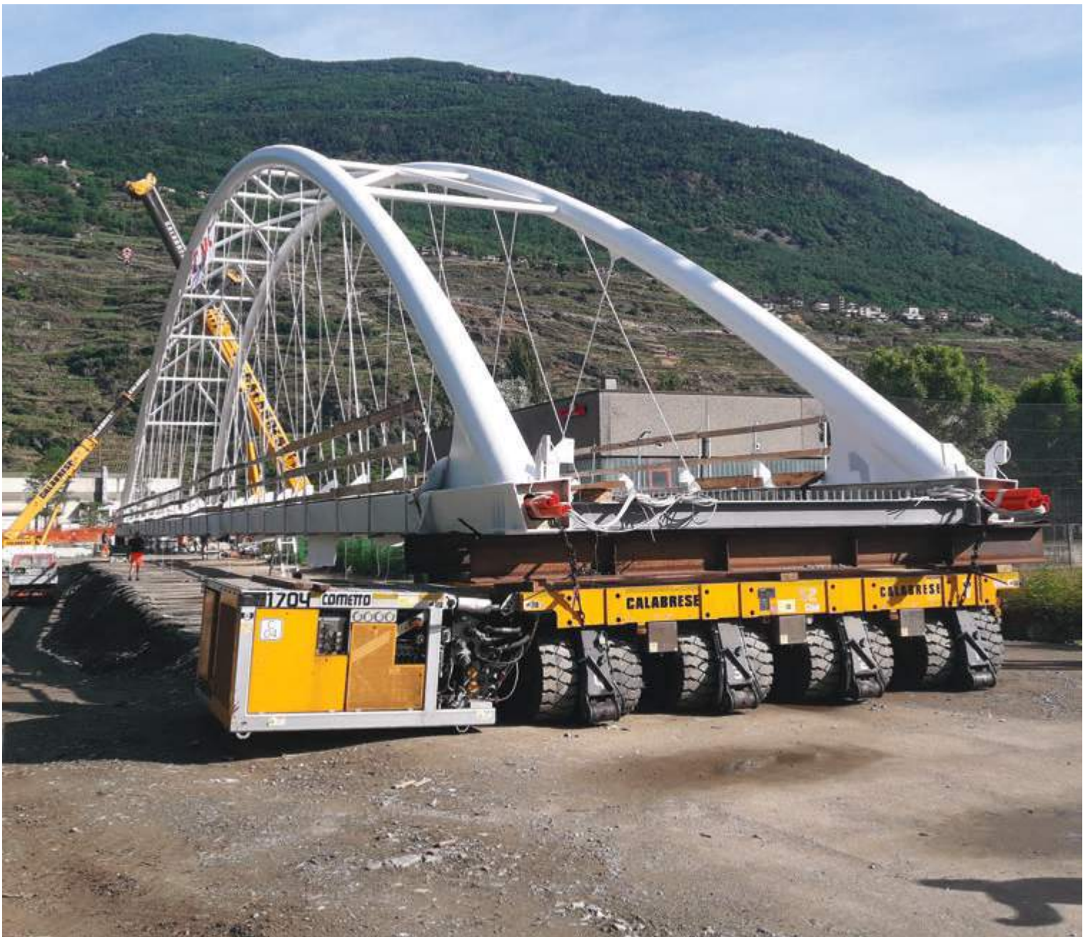
Fig. 31 | Carrello di varo per traslazione appoggio a tergo della spalla.
