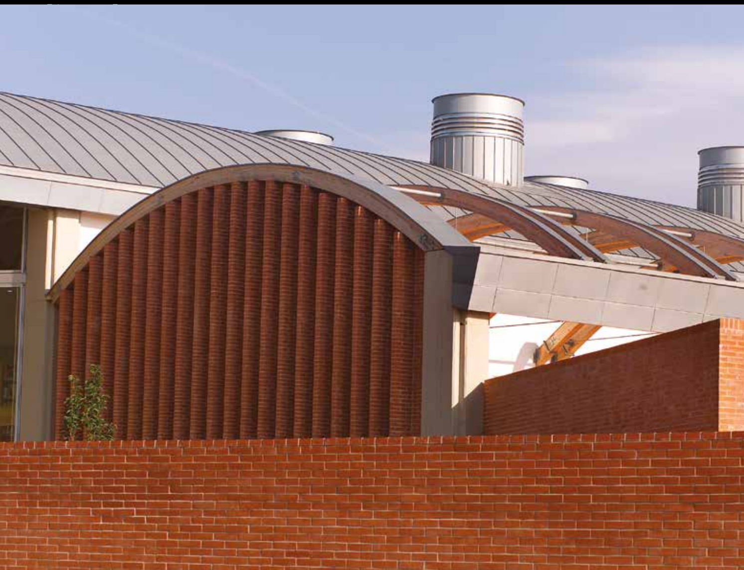
11 Detail of the south front, in the roof the air and light chimneys / Dettaglio del fronte sud, in copertura i camini d'aria e di luce. 12 The north fire escape / La scala di sicurezza a nord. 13 The reading room in the full-height central gallery, the load-bearing element of the spatial system, in the background Anselm Kiefer's "Die grosse Fracht" / La sala lettura nella galleria centrale a tutta altezza, elemento portante del sistema spaziale, sullo sfondo "Die grosse Fracht" di Anselm Kiefer.
