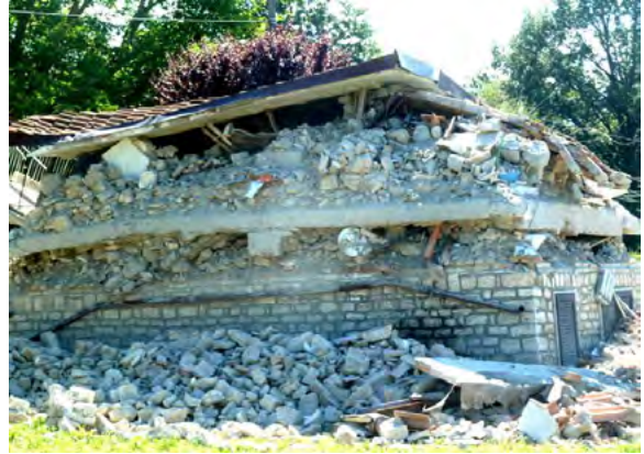
Fig. 10 - Un esempio di applicazione della normativa del 1975 su edifici tradizionali: Villa San Lorenzo e Flaviano, frazione di Amatrice (Rieti), dopo il terremoto del 24 agosto 2016. L'immagine mostra il collasso totale di una casa in muratura con solai in cemento armato, rimasti quasi intatti (Atlante, Centro e Nord, pag. 67, in De Marco e Guidoboni, 2023).
