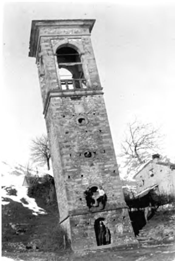
Fig. 8 - Effetti del terremoto del 7 settembre 1920 a Febbio (Reggio Emilia), oggi nota meta turistica nell'Appennino reggiano. Il paese fu estesamente danneggiato e si attivò una grande frana, che fece inclinare paurosamente il campanile della chiesa (Atlante, Centro e Nord, p. 608).
