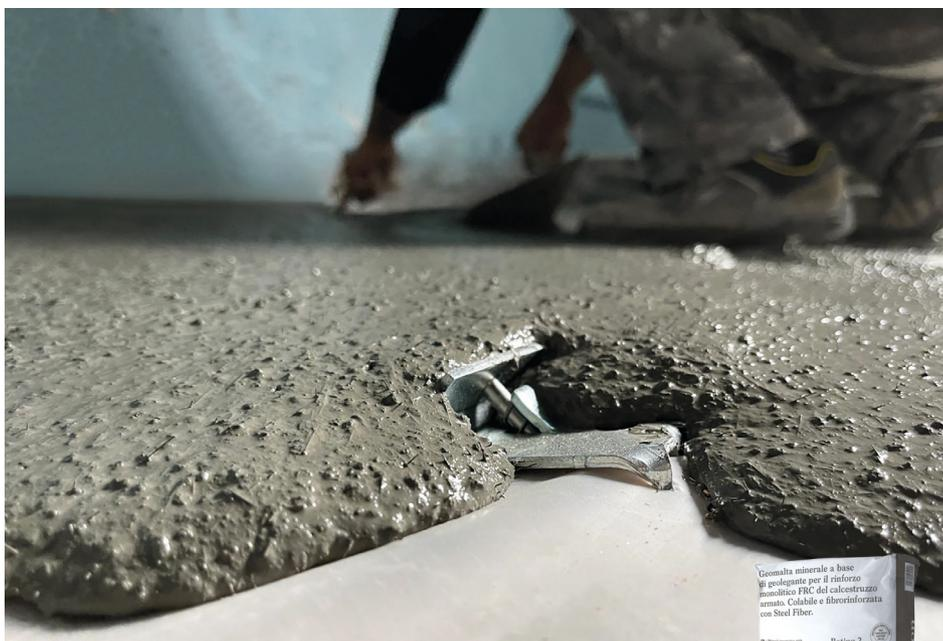
Steel Connect è la gamma di connettori perimetrali e verticali, marcati CE, progettati per garantire semplicità di installazione ed elevate prestazioni, anche in combinazione con sistemi a basso spessore Geolite FRC – Geolite Magma Xenon & Steel Fiber. L'innovativa proposta di Kerakoll include Steel Connect Wall, per la realizzazione di diaframma di piano, Steel Connect C, per il rinforzo a flessione di solai in c.a. e Steel Connect W, per il rinforzo a flessione di solai in legno.
