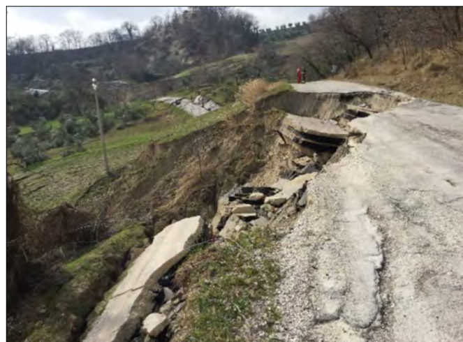
FIGURA 2. Particolari della frana di Ponzano; a sinistra la spalla destra di scorrimento; a destra un tratto a monte della scarpata principale.
